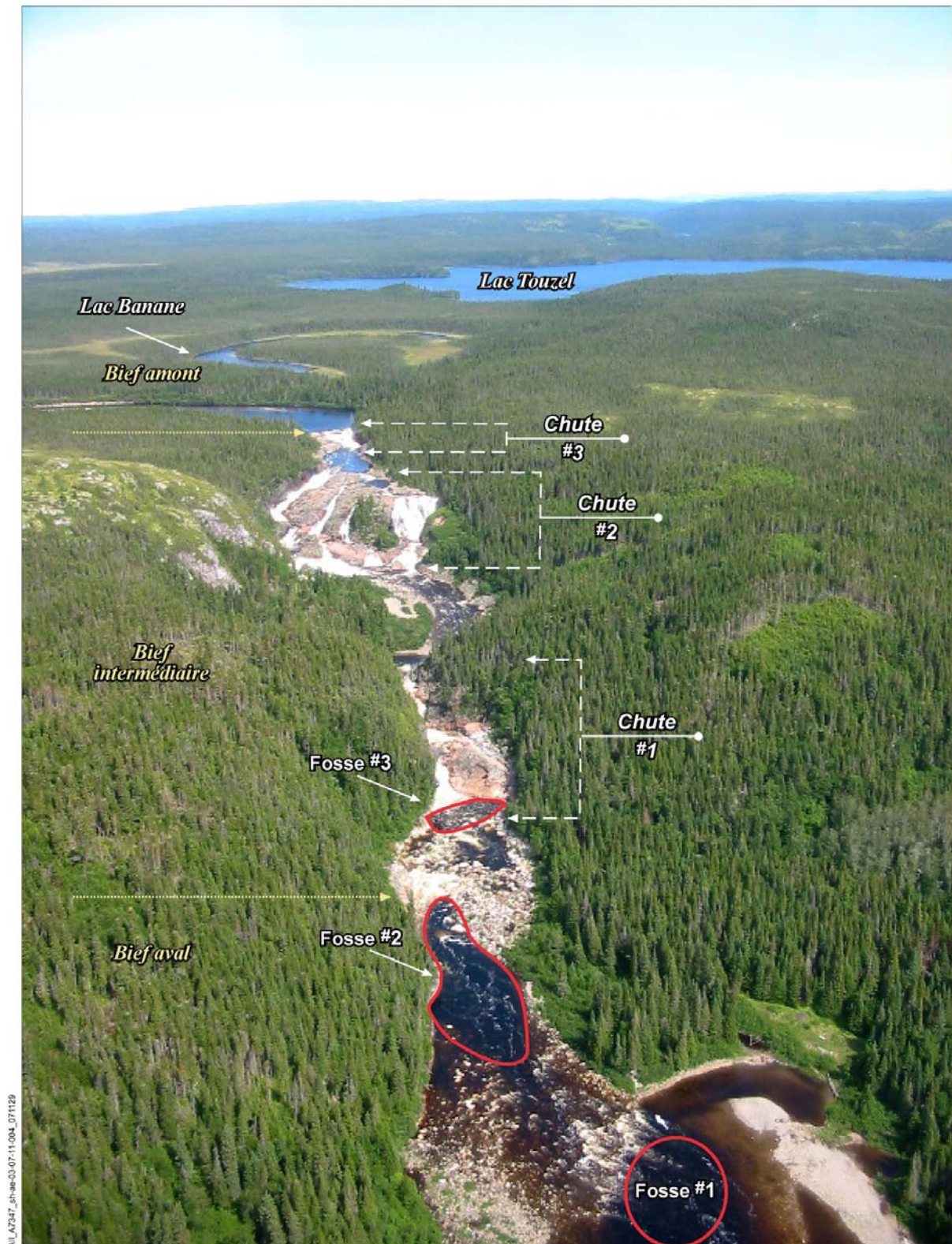
Figure 2.2 : Site de l'aménagement hydroélectrique projeté (Courbe du Sault)
