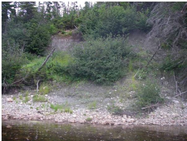
Photo 7.1 : Talus d'argile en rive droite partiellement stabilisé par la végétation (ZE4)
