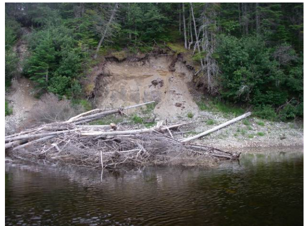
Photo 7.2 : Zone d'érosion active en rive droite (ZE5)
