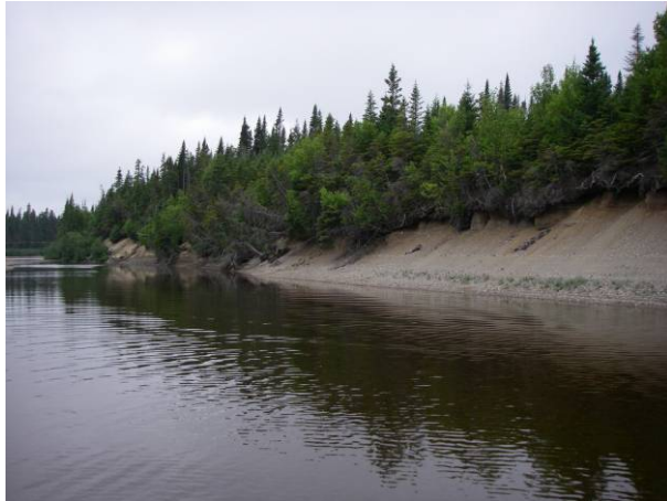
Photo 7.3 : Talus instable de sable et gravier en rive gauche (ZE1)
