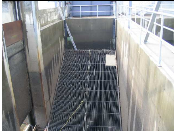
Figure 1 : Grille fine utilisée à la centrale de la Chute-à-Gorry sur la rivière Ste-Anne
