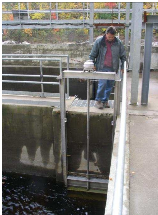
Figure 3 : Vue du pertuis submergé entre les deux canaux de la prise d'eau
