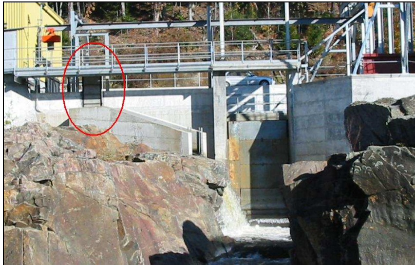
Figure 2 : Vue extérieure de la passe à poissons
