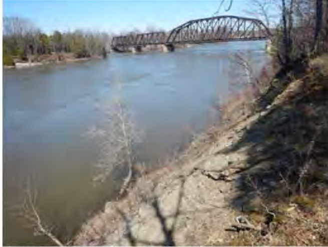
Vue de la rive sud abrupte et érodée de la rivière des Prairies, à l'ouest du rail existant; photo prise en faisant face à l'est.
