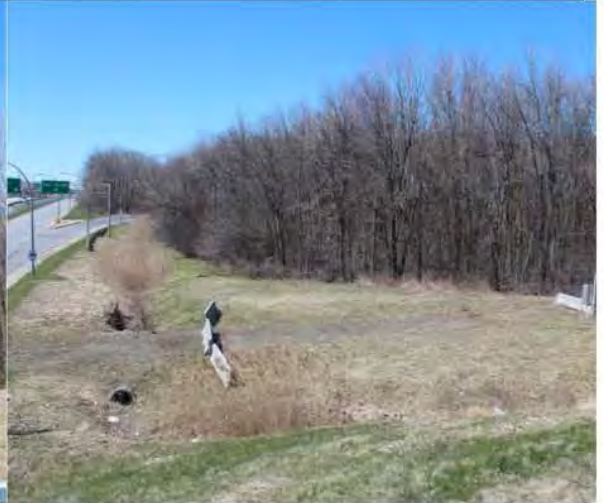
Viaduc boulevard Morgan sur A-40 – Vue vers l'ouest
