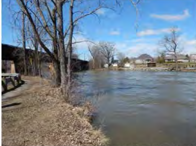
Vue de la rive sud de la rivière des Prairies, à l'est du rail existant; photo prise en faisant face au nord
