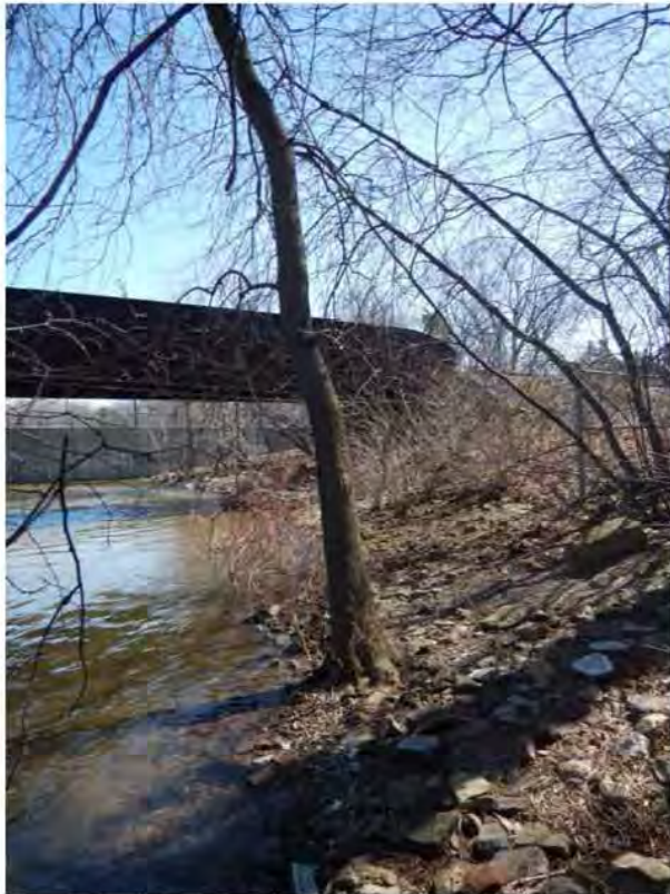
Vue de la rive sud de la rivière des Mille-Îles, à l'ouest du rail existant; photo prise en faisant face à l'est
