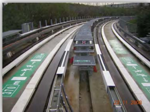
Photographie 7-5 – Exemple de 3e rail sur le véhicule automatique léger Ligne 1 de Roissy – Charles-de-Gaulle (France)
