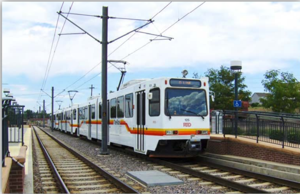
Photographie 7-7 – Exemple d'implantation caténaire avec mâts centraux — LRT (Colorado)
