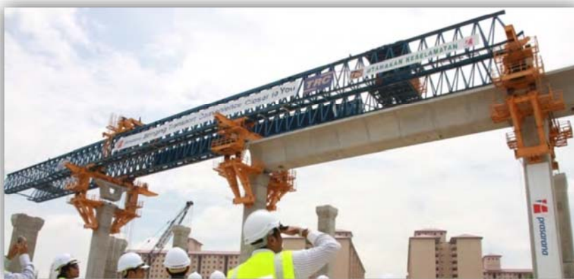
Photographie 7-13 – Voussoirs suspendus à la poutre de pose
