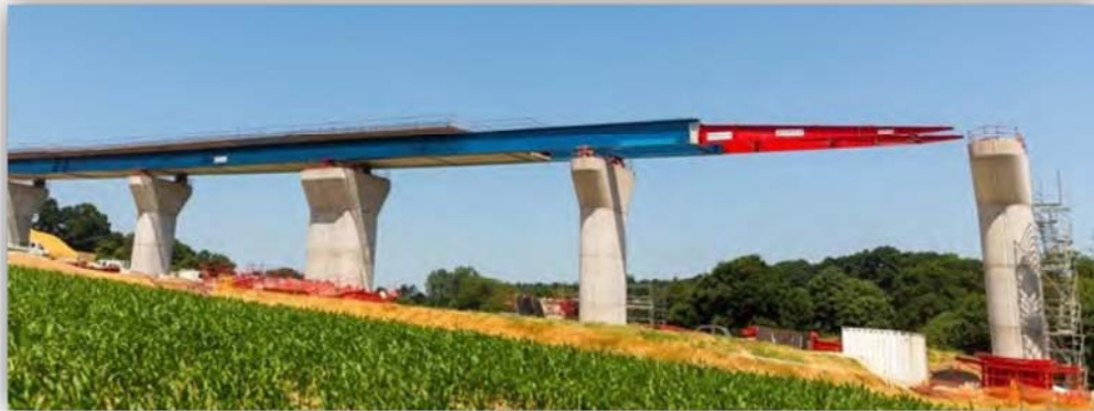
Photographie 7-16 – Exemple de charpente en acier mise en place par lançage
