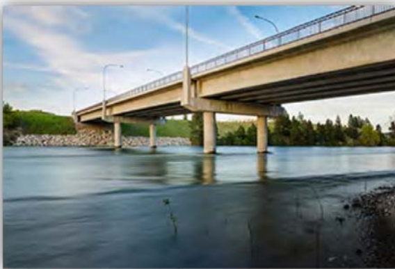
Poutres préfabriquées en béton précontraint par prétension (Appleway Bridge, É.-U.) (Source : www.oldcastleprecast.com )
