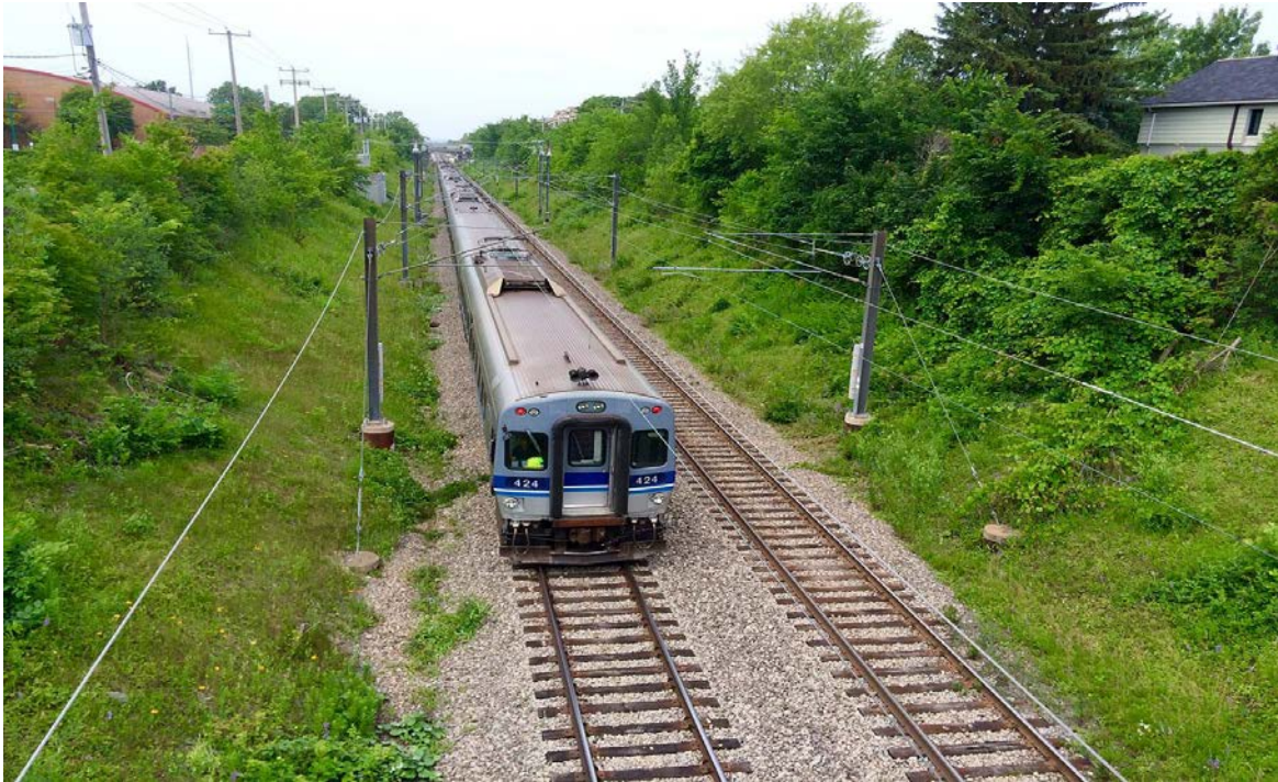
Figure 5-6 : Exemple de voie ballastée double (Deux Montagnes entre la gare Bois-Franc et la Gare Centrale)
