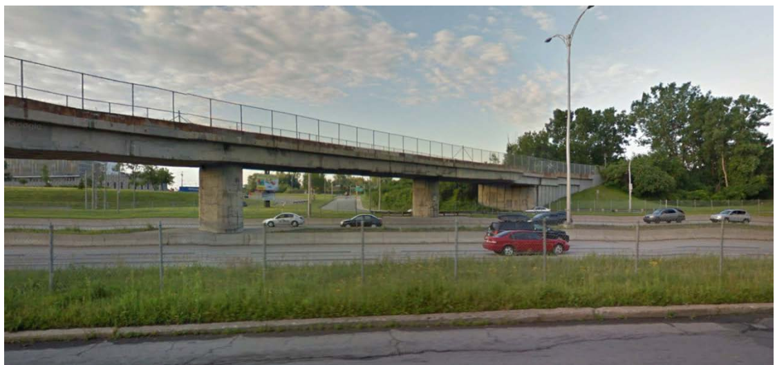
Figure 5-13 : Exemple d'étagement de voie ferrée (2)
