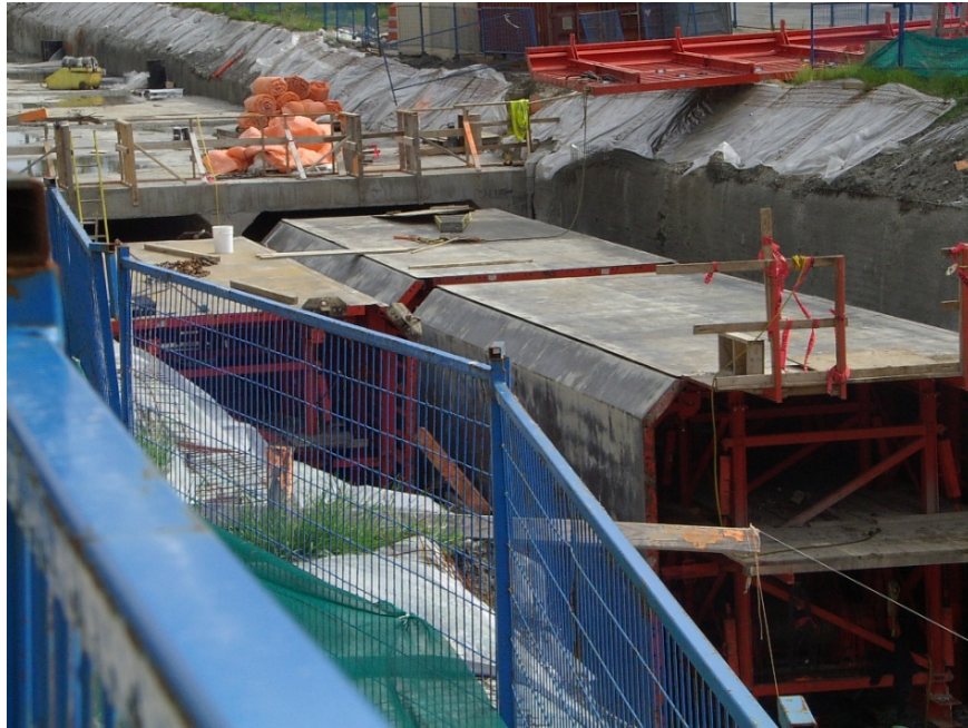
Figure 5-28 : Exemple de construction en tranchée couverte - Skytrain de Vancouver (2)
