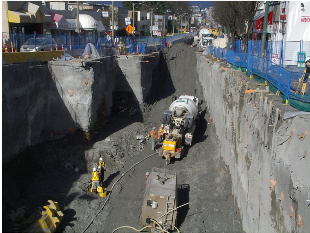
Figure 5-30 : Exemple de construction en tranchée couverte - Skytrain de Vancouver (4)
