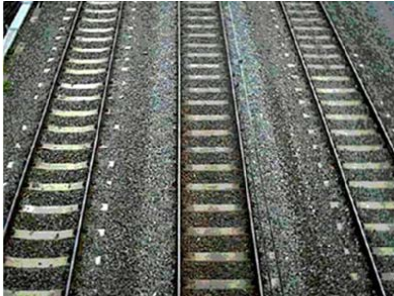
Figure 5-25 : Travaux au sol
