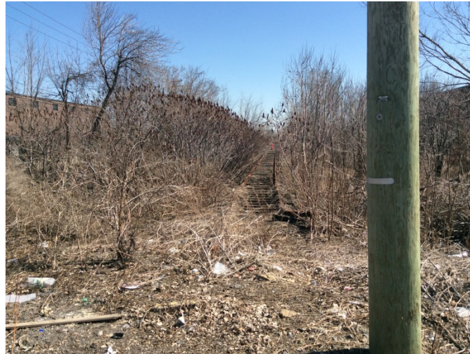
Photographie 4-1 : Fin de la voie ferrée dans l'emprise Doney (hauteur rue Davis)
