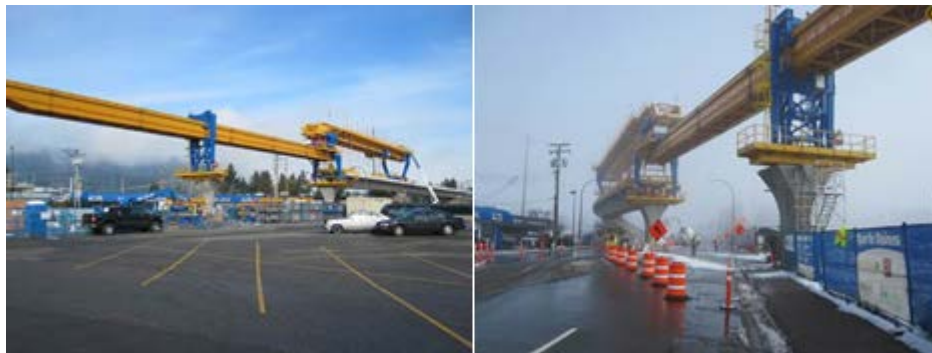
Figure 5-26 : Technique envisagée pour la pose des voussoirs
