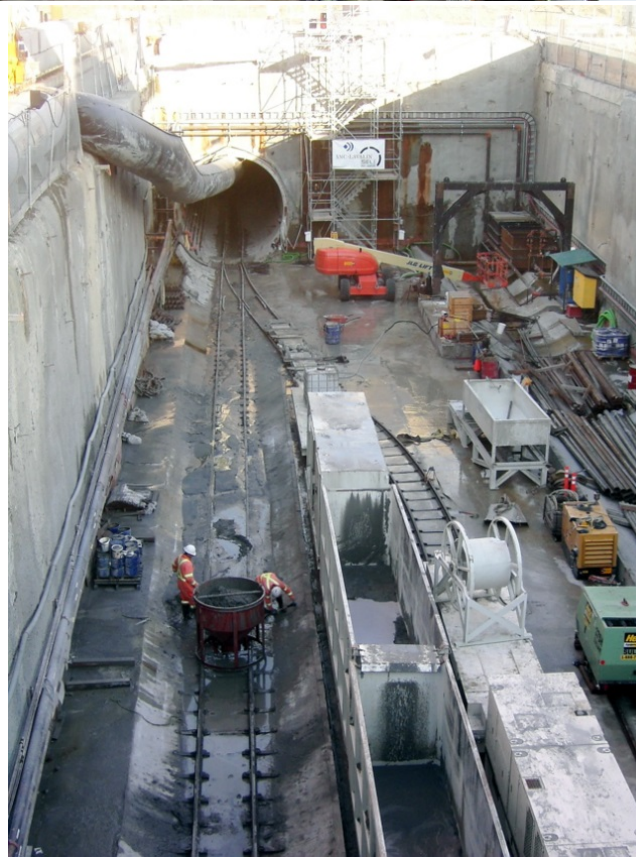
Figure 5-32 : Construction d'un tunnel pour le Skytrain à Vancouver
