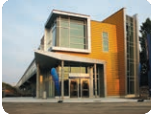
La gare Pointe-aux-Trembles
