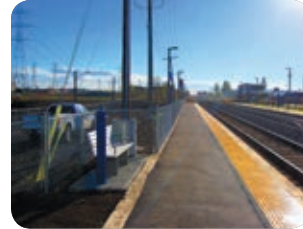
Le 2 e quai permanent de la gare Saint-Léonard
