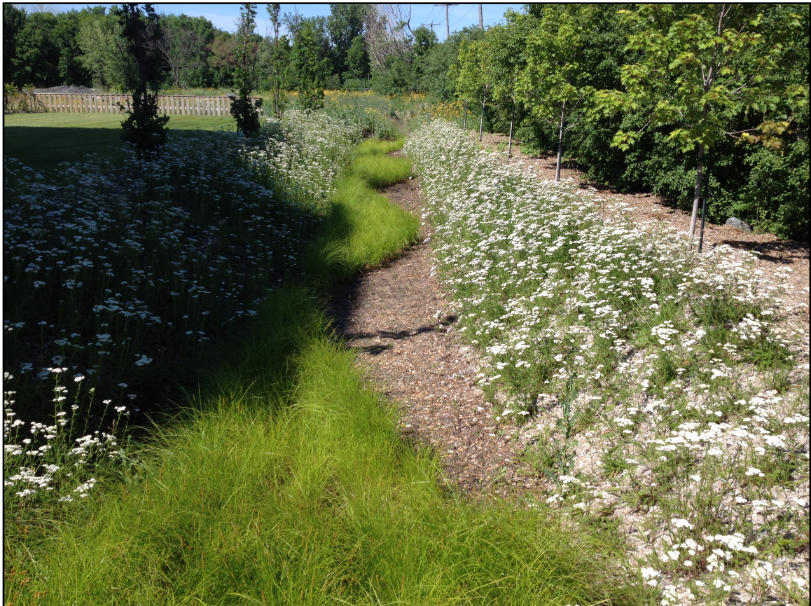
Photo 1: Noue pour une gestion environnementale des eaux du projet Greenwich (Pointe-Claire)
