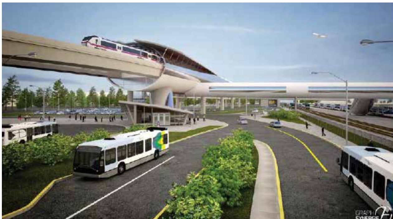
Figure 7,5 : Gare intermodale de Dorval du SLRO en 2014
