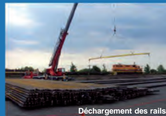
Déchargement des rails
