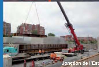
Déchargement des rails
