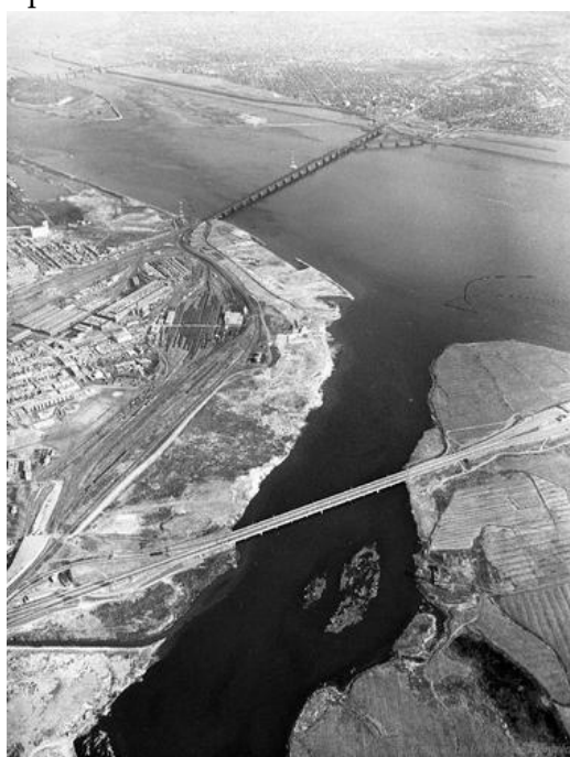
Figure 13 Vue aérienne des travaux de remplissage de l'Autoparc Victoria (Archives de Montréal, VM94-EX13-009_141)
