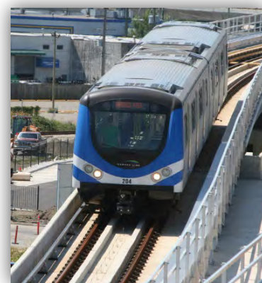
Photographie 8-6 : TransLink's Canada Line OMC, Vancouver, Canada
