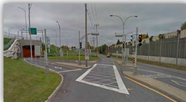
Photographie 4-1 : Photo : Accès au tunnel Chevrier via le boulevard Lapinière (Source : Google StreetView)
