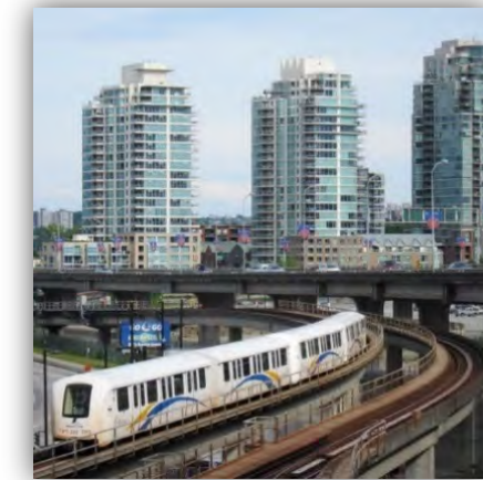
Photographie 8-2 : Site propre protégé, Skytrain, viaduc Dunsmuir entre la station Chinatown et le centre-ville de Vancouver, Canada
