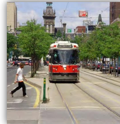
Photographie 8-1 : Site propre partagé, ligne sur Spadina Avenue, Tramway de Toronto, Canada
