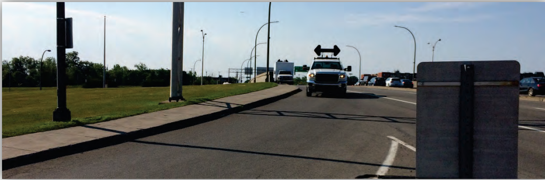
Photographie 2-6 — Bretelle d'accès à l'A40 Ouest pour les conducteurs provenant du boulevard Saint-Charles direction nord
