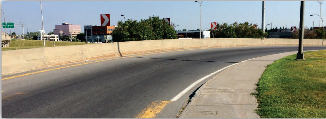
Photographie 2-10 – Bretelle d'accès à l'A40 Ouest pour les conducteurs provenant du boulevard Saint-Charles direction nord
