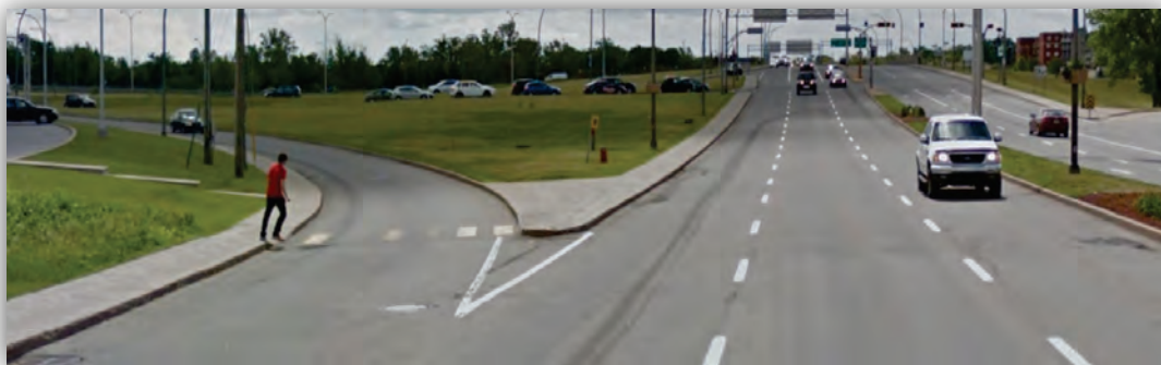
Photographie 2-7 — Bretelle de sortie à l'A40 Ouest pour les conducteurs désirant circuler sur le boulevard Saint-Charles direction nord
