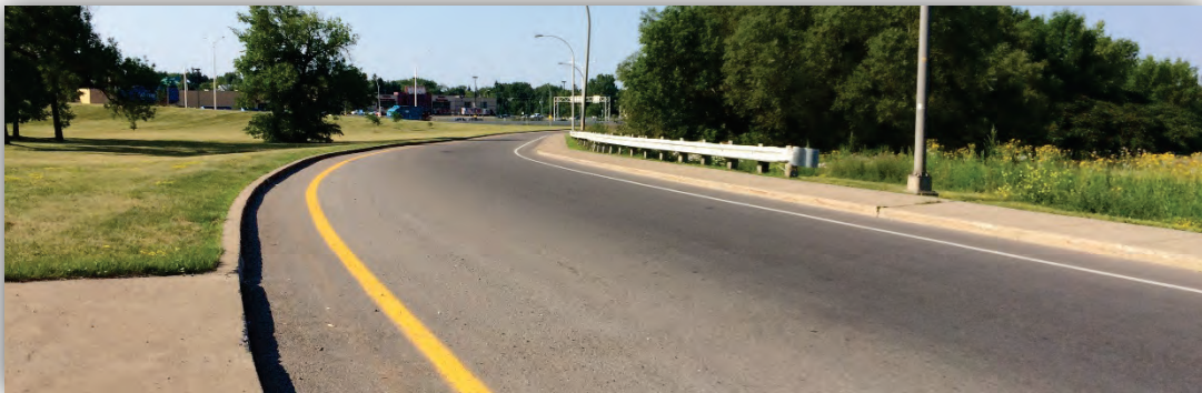
Photographie 2-5 — Bretelle d'accès à l'A40 Ouest pour les conducteurs provenant du boulevard Saint-Charles direction sud
