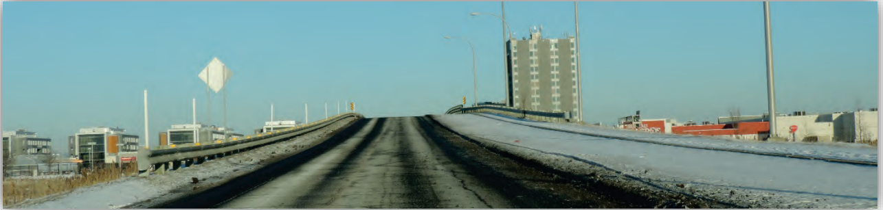
Photographie 2-3 — Viaduc du boulevard Rome, direction nord
