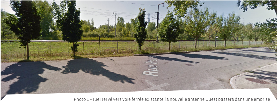
Photo 1 – rue Hervé vers voie ferrée existante, la nouvelle antenne Ouest passera dans une emprise au sud de cette voie ferrée existante au premier plan, du côté sud du boisé sur la photo
