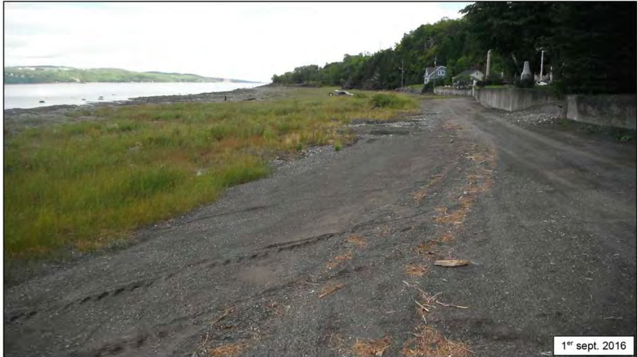
Figure 3.7 État des lieux – secteur C (ch. approx. 1+040, vue vers l'est).
