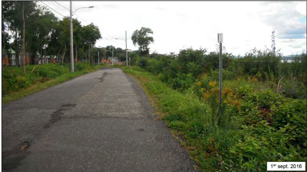
Figure 3.2 État des lieux – secteur A (ch. approx. 0+350, vue vers l'ouest).
