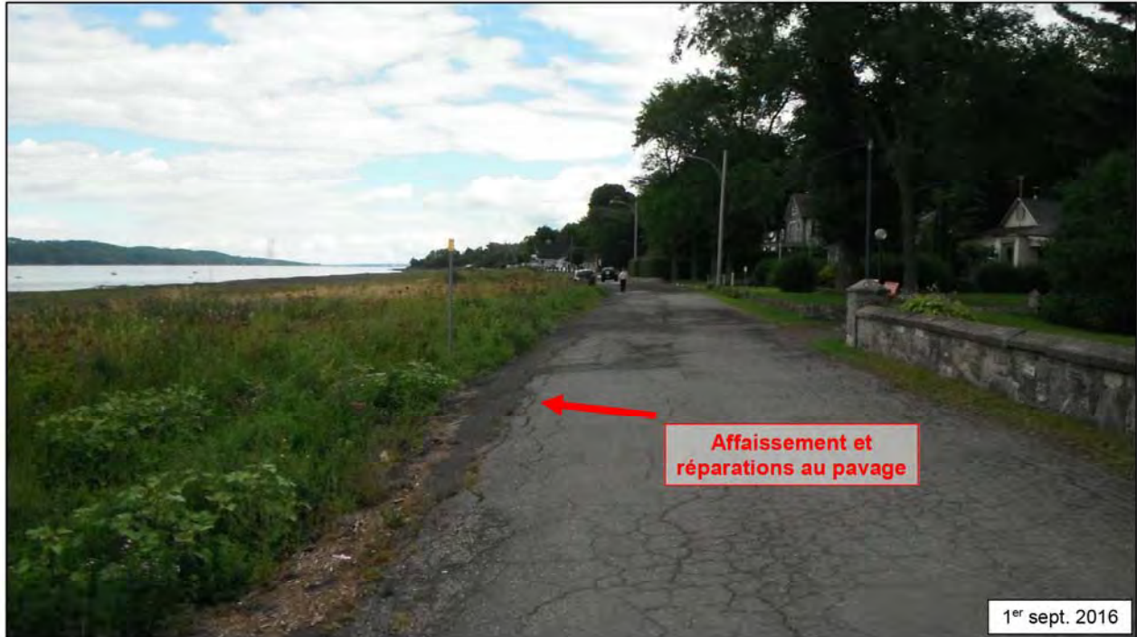
Figure 3.3 État des lieux – secteur B (ch. approx. 0+500, vue vers l’est).
