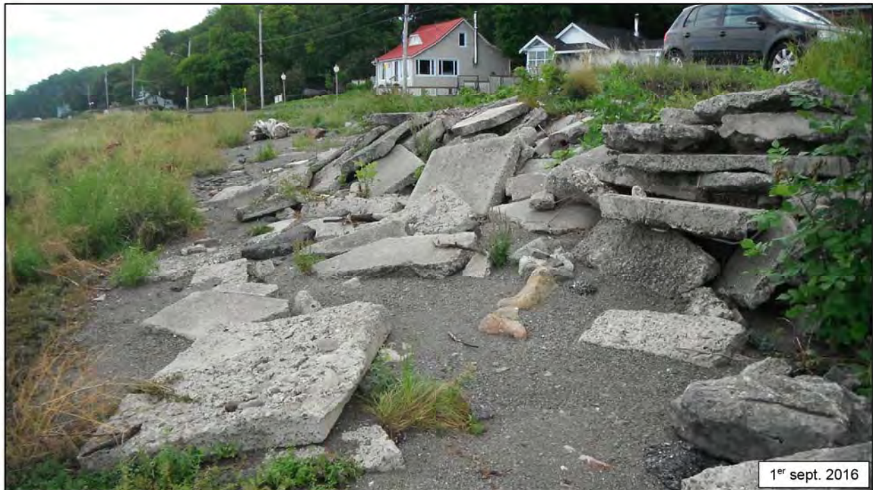
Figure 3.5 État des lieux – secteur B (ch. approx. 0+875, vue vers l'est).
