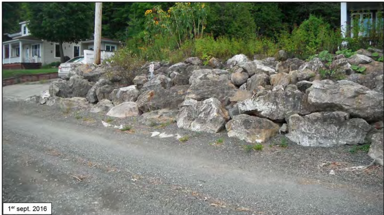
Figure 3.9 Revêtement de protection en enrochement existant n° 2 (ch. 1+050 à 1+090).
