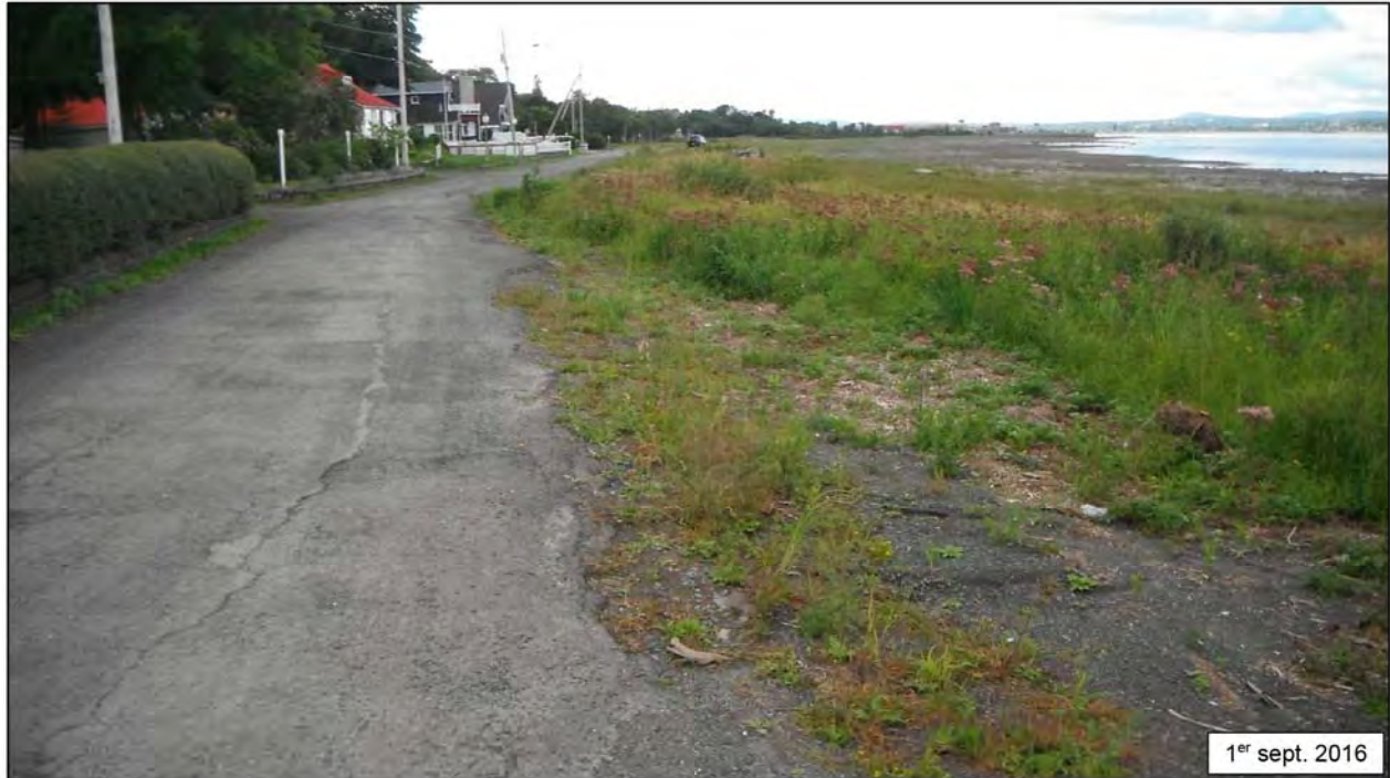
Figure 3.6 État des lieux – secteur B (ch. appox. 1+020, vue vers l'ouest).
