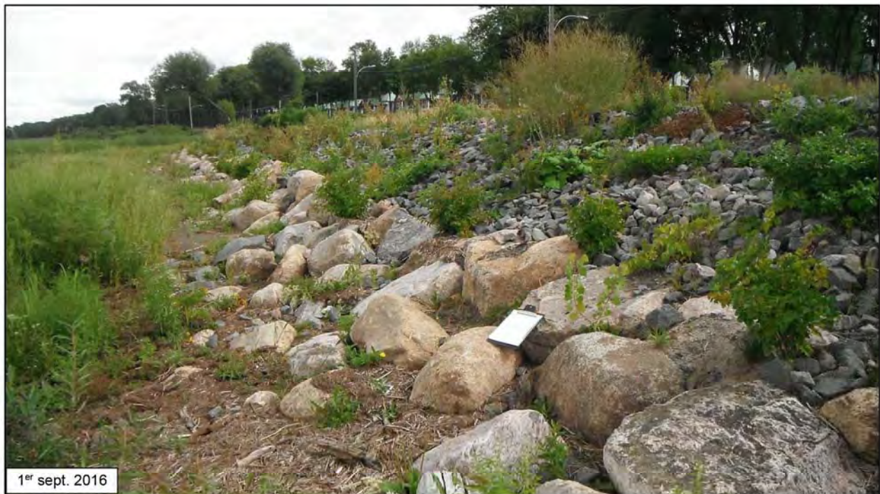
Figure 3.8 Revêtement de protection en enrochement existant n° 1 (ch. 0+020 à 0+080).
