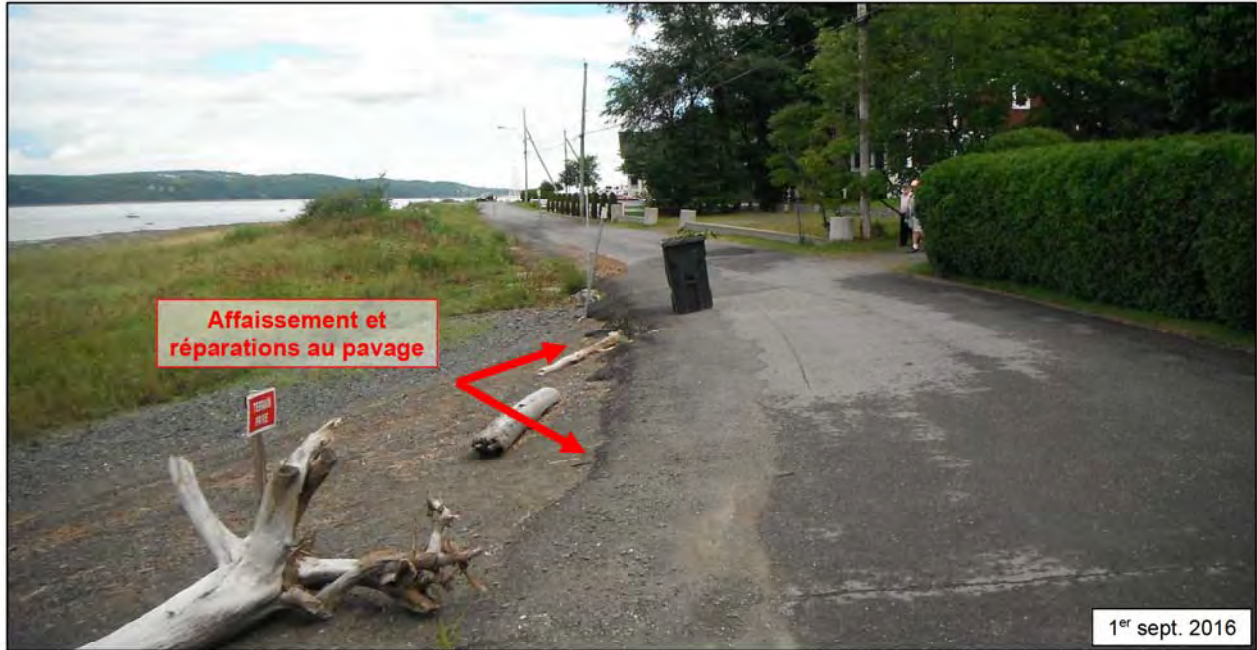
Figure 3.4 État des lieux – secteur B (ch. approx. 0+720, vue vers l'est).
