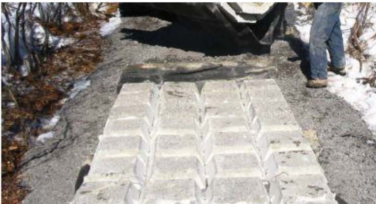
Photo 2.1 Tapis de béton flexible avec blocs de forme prisme à base trapézoïdale
