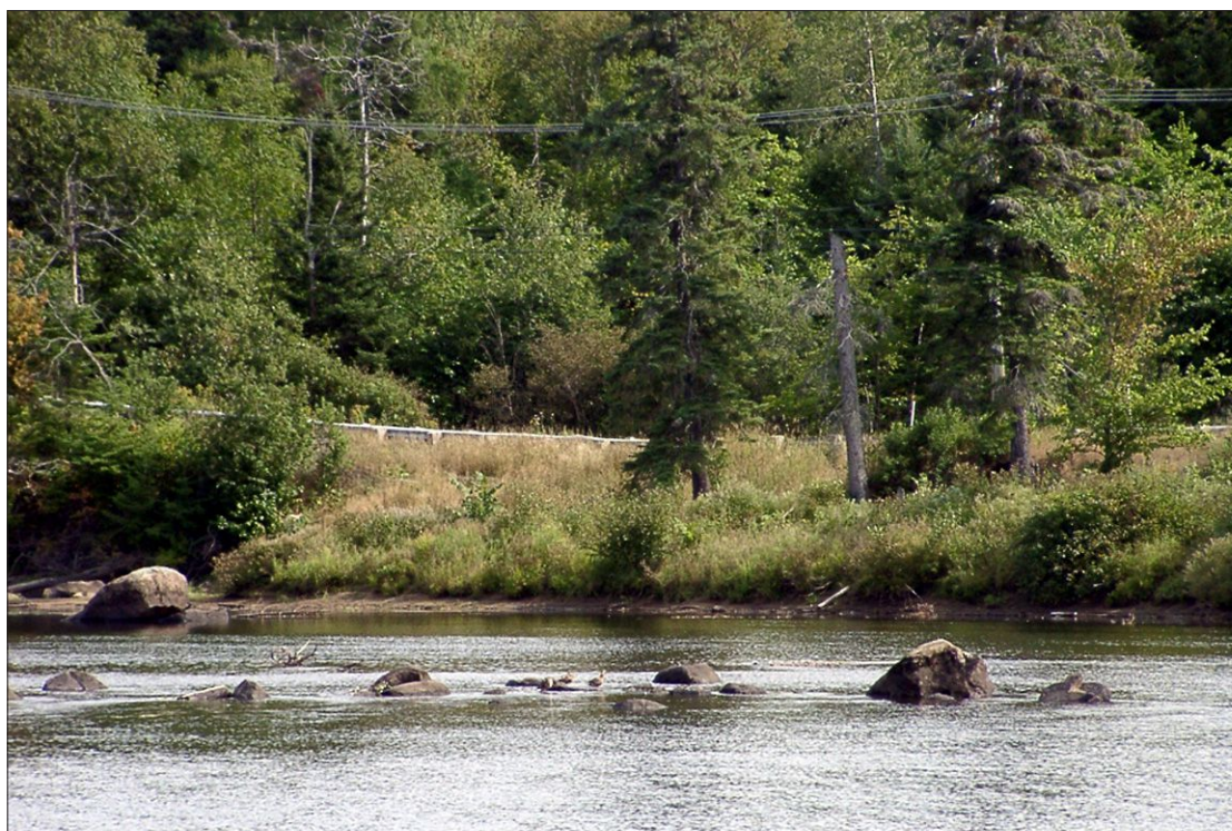
Photo 2 Vue du talus riverain de la rivière Jacques-Cartier et de la route 369 au segment 1 (septembre 2002).
