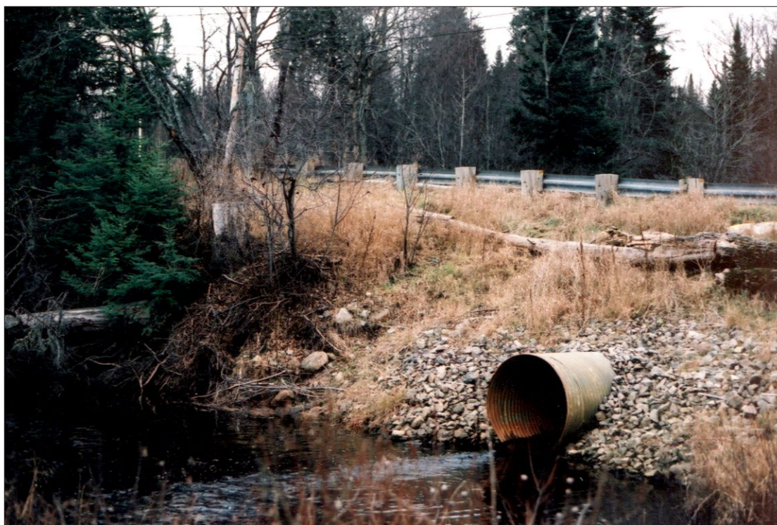
Photo 4 Ponceau (diamètre de 1200 mm) en aval du segment 1 (novembre 2001).
