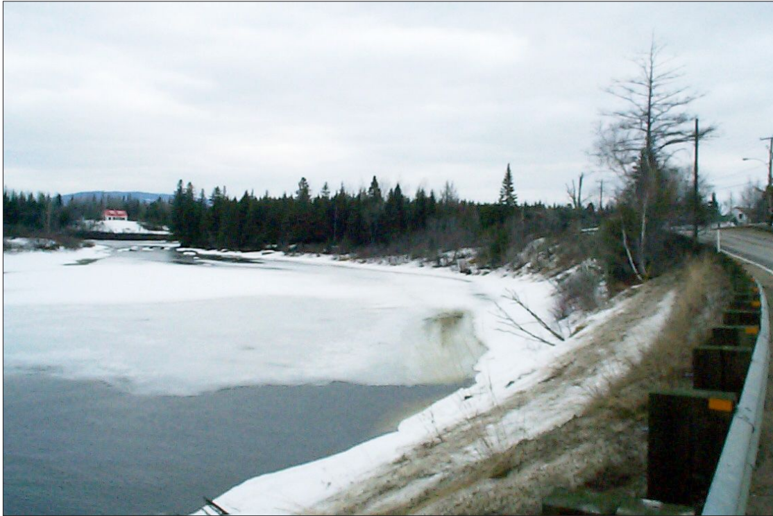
Photo 9 Vue du talus riverain de la rivière Jacques-Cartier et de la route 369, vers l'est, en amont du segment 3 (avril 2002).
