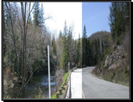
Les éléments de conception correspondent aux normes d'une route régionale pour une vitesse affichée de 90 km/h. Le profil en travers est de type C avec fossé de part et d'autre de la route. Les voies ont une largeur de 3,5 m avec des accotements de 2,5 m, dont 1,75 m pavé à des fins cyclables tel que demandé par le milieu. L'emprise nominale est de 30 m.
