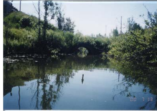
Photo 22 – Décharge du petit cours d'eau dans la rivière Cabano en amont du pont
