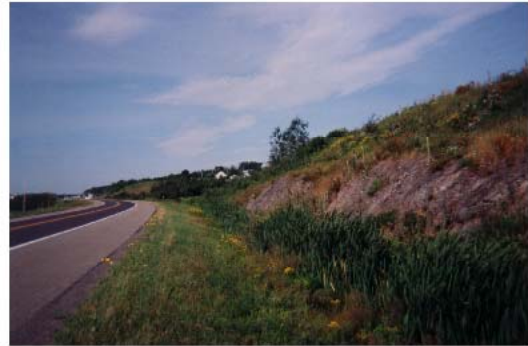
Photo 7 – Exemple de canal de drainage intermittent, route 185, secteur de Cabano
