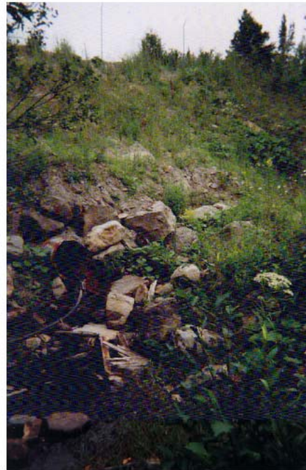
Photo 14 – Digue de contrôle, secteur en amont du ruisseau des Ha! Ha!
