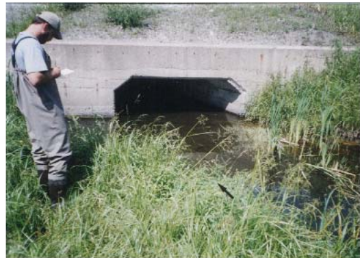
Photo 19 – Ponceau de la route 185 sur le ruisseau à Bernard (face en amont)
