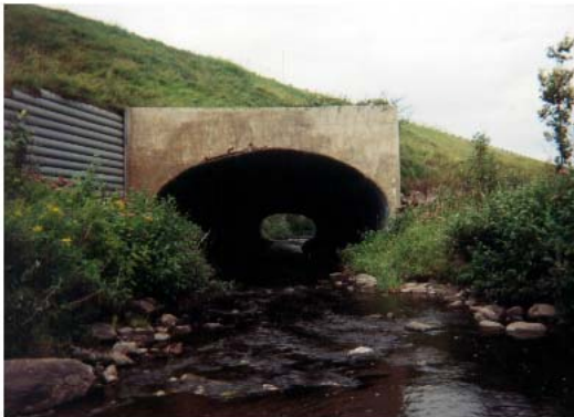
Photo 16 – Ponceau actuel de la route 185 sur la Petite rivière Savane
