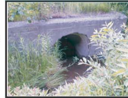
Situation en amont de la route 173.
