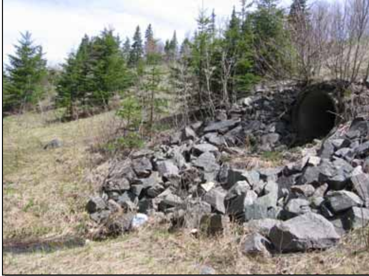
Photo 17 Enrochement à la sortie d'un ponceau situé du côté ouest de la route (photo prise le 9 mai 2006)
