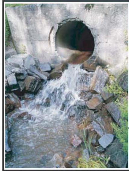
Situation du ponceau en aval de la route 173.
