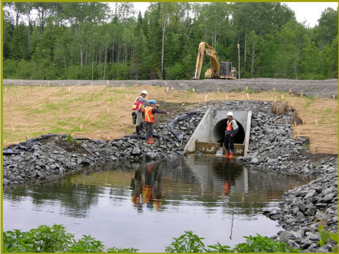
Figure 12.1 Équipe de surveillance sur un chantier de construction du ministère des Transports.
