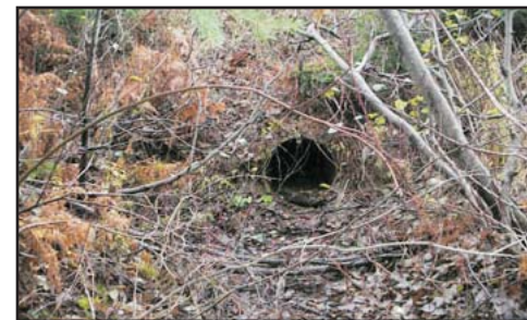
Vue aval du ponceau
