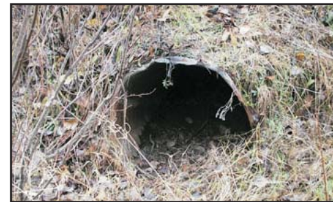
Vue amont du ponceau
