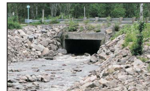
Vue aval du ponceau
