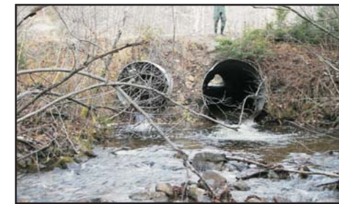
Vue aval des ponceaux
