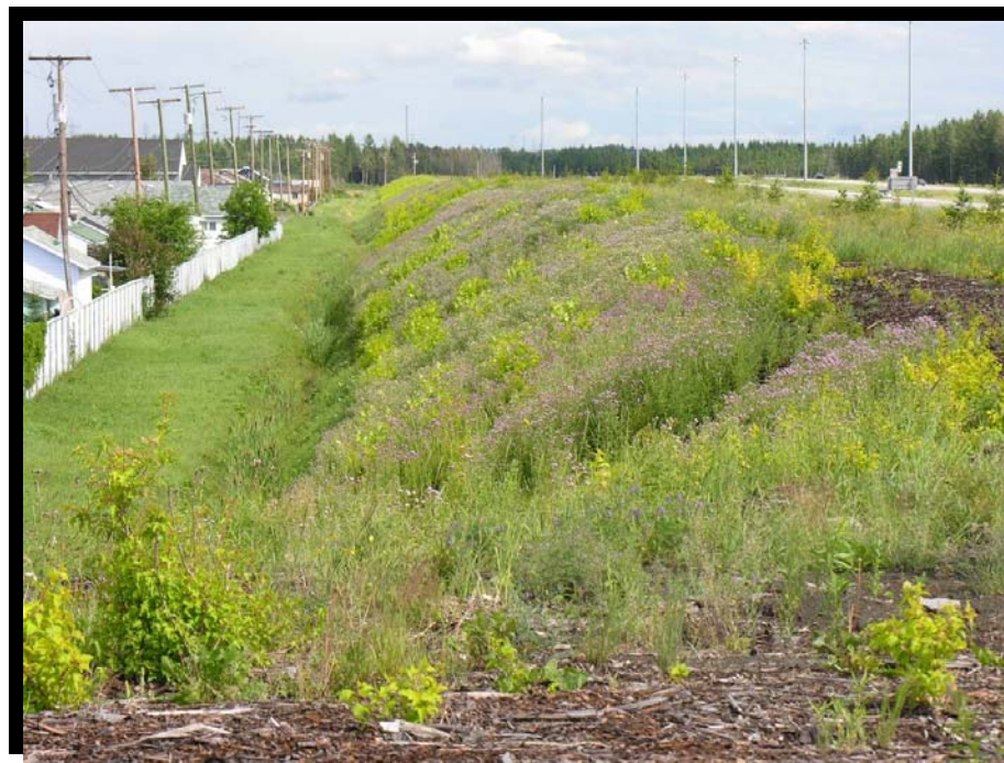
FIGURE 171 Butte antibruit d'une hauteur de 5,5 m, aménagée en bordure du quartier résidentiel de la rue Lesage. Autoroute 70 à Jonquière, secteur du carrefour Mathias. (2005.1177)
