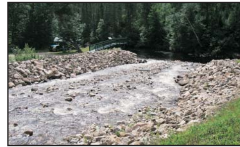
Photo 1 – Vue vers l'aval au chaînage 1+050
