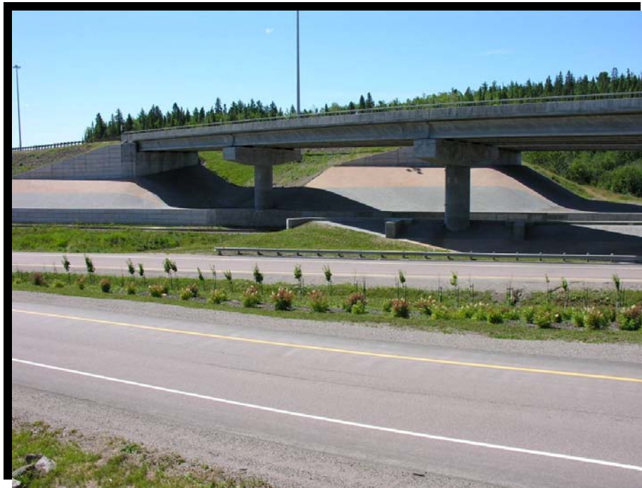
Figure 172 Aménagement paysager d'un carrefour étagé à la limite ouest de la ville de Saguenay. Engazonnement, plantation et pose de pavés (2 couleurs) au pied des culées. Autoroute 70 à Jonquière. (2005.1178)
