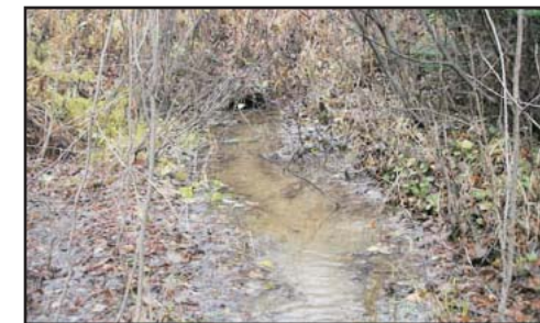
Vue aval du ponceau
