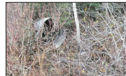
Vue aval du ponceau
