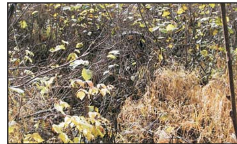
Vue amont du ponceau
