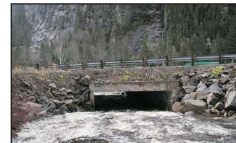
Vue amont du ponceau
