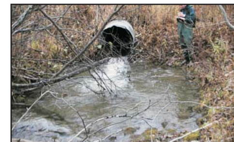
Vue aval du ponceau
