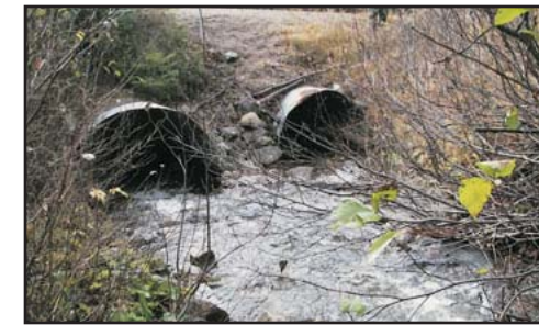
Vue amont des ponceaux
