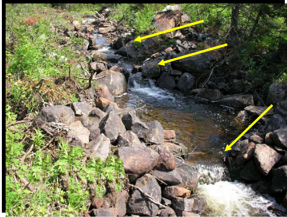
FIGURE 152 Nettoyage et reprofilage du cours d'eau, stabilisation des berges, aménagement de frayères et construction de seuils pour la montaison de l'omble de fontaine. Sur ce tronçon du cours d'eau, les seuils sont fabriqués avec des pierres. Route 175 dans la réserve faunique des Laurentides, au kilomètre 181, secteurs du lac Tourangeau et du lac Daran. (2005.1159)
