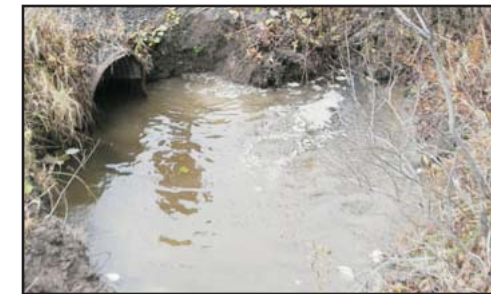
Vue amont du ponceau
