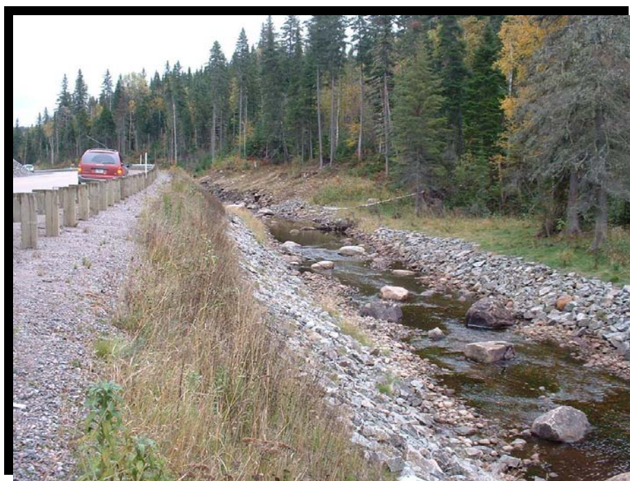
FIGURE 151 Aménagement d'une frayère pour l'omble de fontaine. Pierres en quinconce encastrées dans le lit du cours d'eau de part et d'autre de la frayère. Route 381 à Ferland-et-Boilleau, rivière Bras d'Hamel. (2002.1153)
