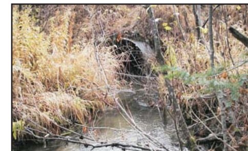
Vue amont du ponceau
