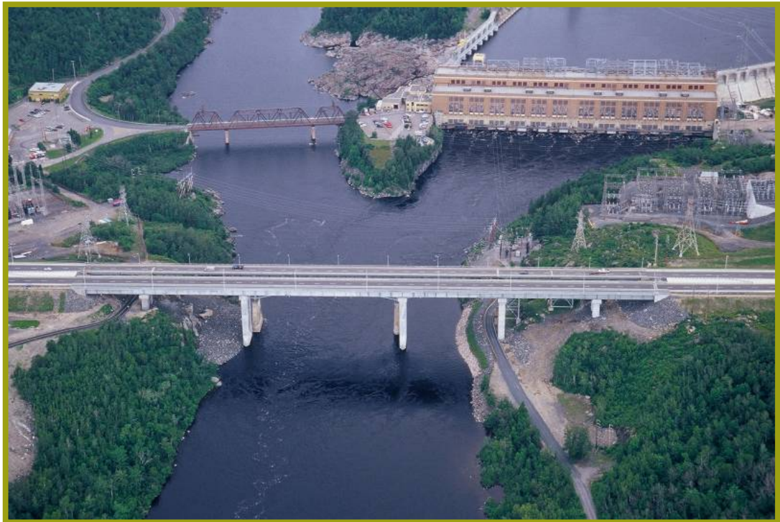
Figure 5.4 Le barrage de l'Isle-Maligne de Rio Tinto Alcan sur la rivière La Grande Décharge à Alma. Le potentiel hydroélectrique de la région a favorisé l'implantation de grandes entreprises.
