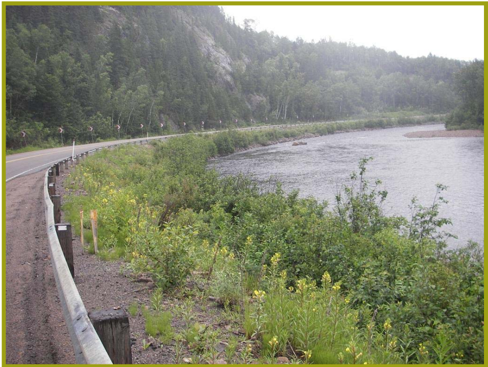
Figure 5.14 Aperçu de la rive gauche de la rivière le long de la route 172 (chaînage 7+100).
