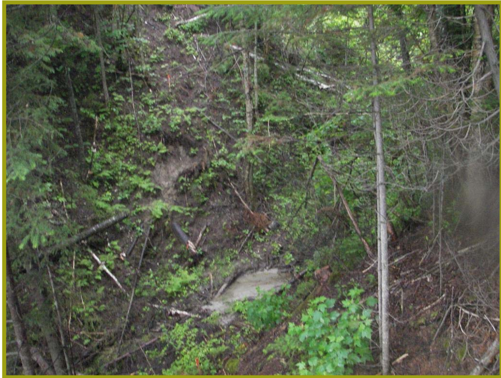
Figure 5.7 Zone d'érosion sur le talus d'une des coulées (chaînage 6+130).
