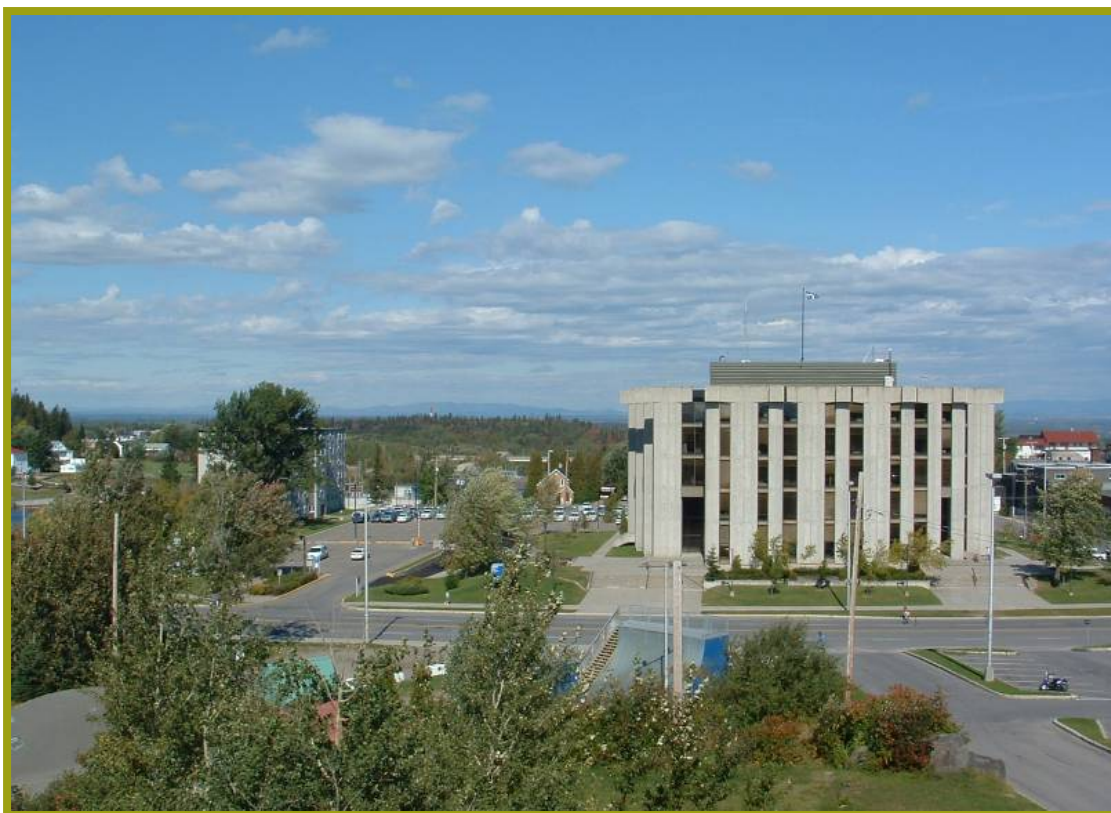
Figure 2.2 Le siège social de la Direction du Saguenay–Lac-Saint-Jean–Chibougamau du ministère des Transports du Québec est situé dans l'édifice Marguerite-Belley à Jonquière.
