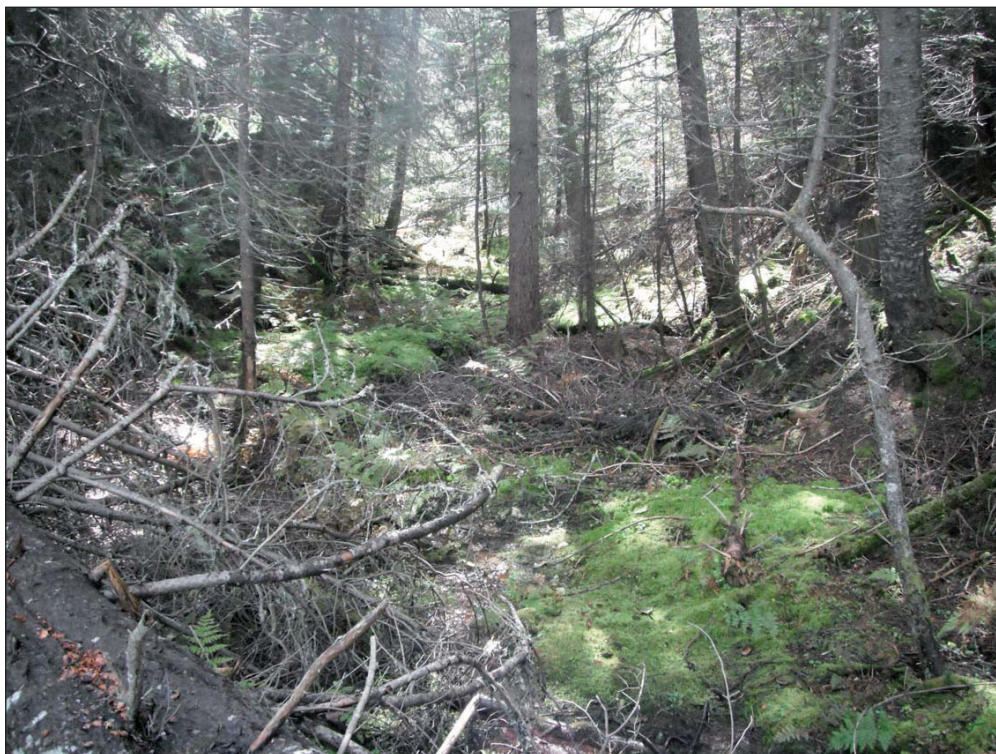
Photo 6 Aval du ponceau 0024-2 (drainage pluvial).
