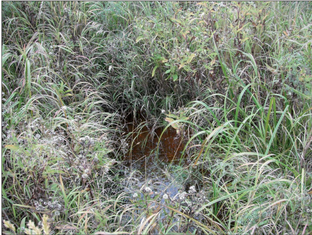
Photo 13 Amont du ponceau 0060-2 (drainage pluvial).
