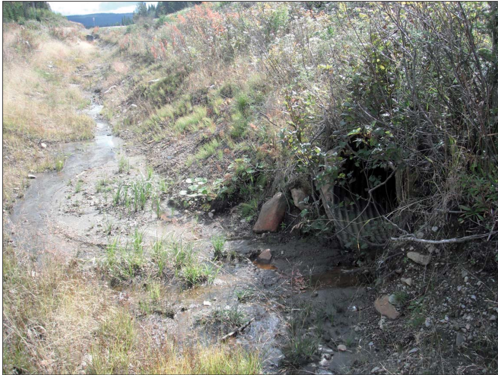
Photo 3 Amont du ponceau 0051-2 (drainage pluvial).
