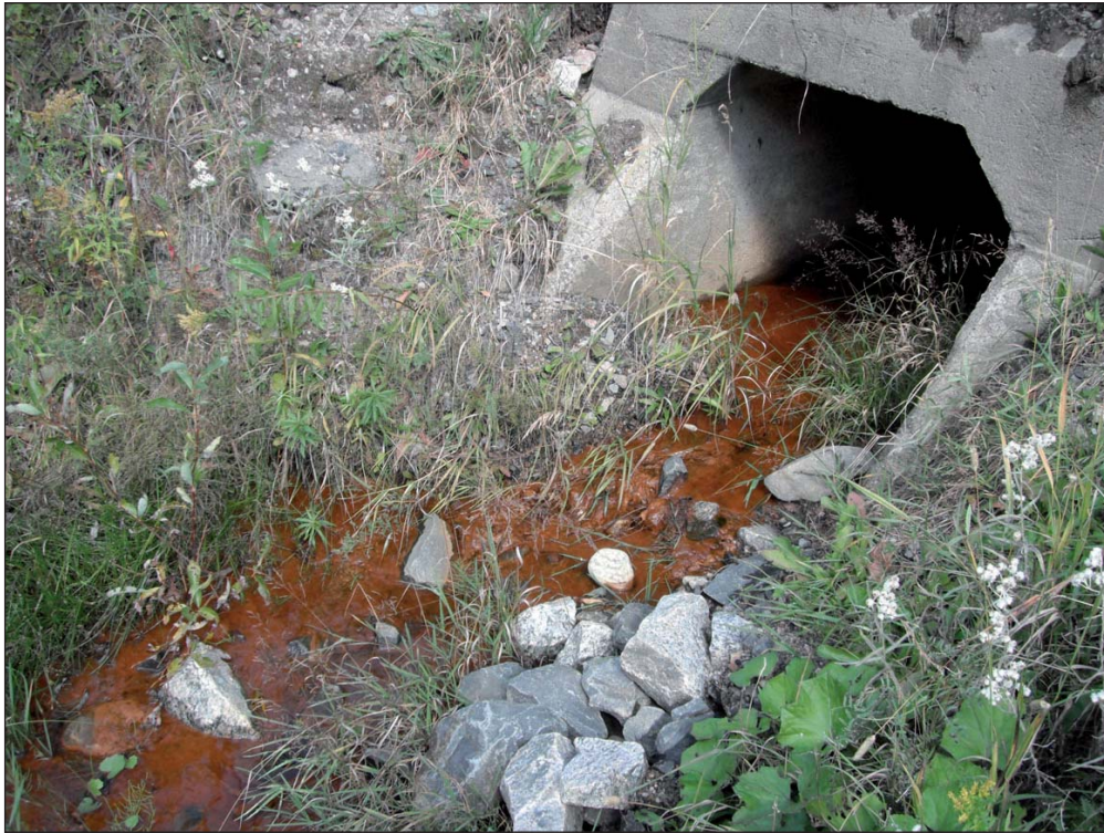
Photo 9 Aval du ponceau 0056-2 (drainage pluvial).
