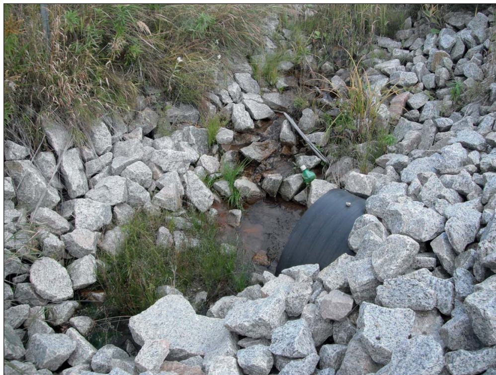
Photo 14 Amont du ponceau 0061-2 (drainage pluvial).
