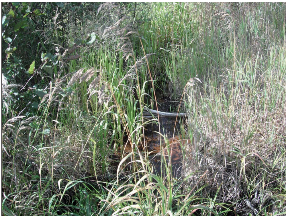
Photo 4 Aval du ponceau 0052-2 (drainage pluvial).
