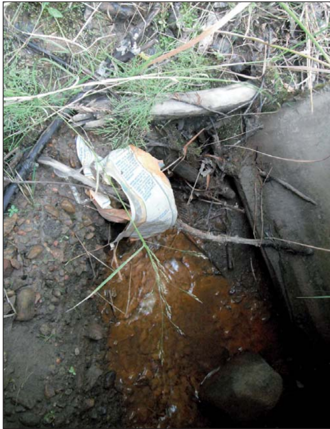
Photo 5 Aval du ponceau 0053-2 (drainage pluvial).
