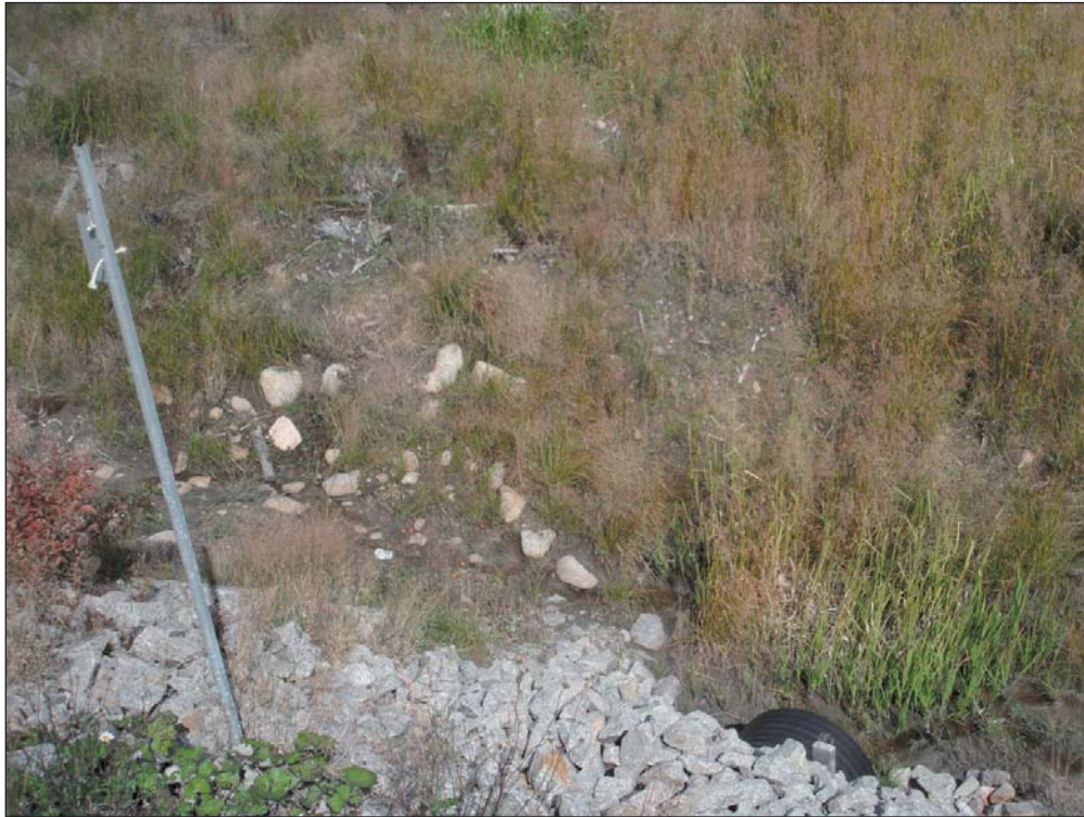
Photo 1 Amont du ponceau 0049-2 (drainage pluvial).
