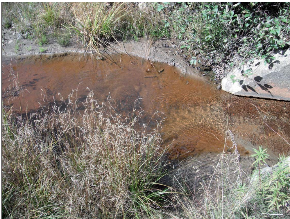
Photo 12 Aval du ponceau 0059-2 (cours d'eau intermittent).
