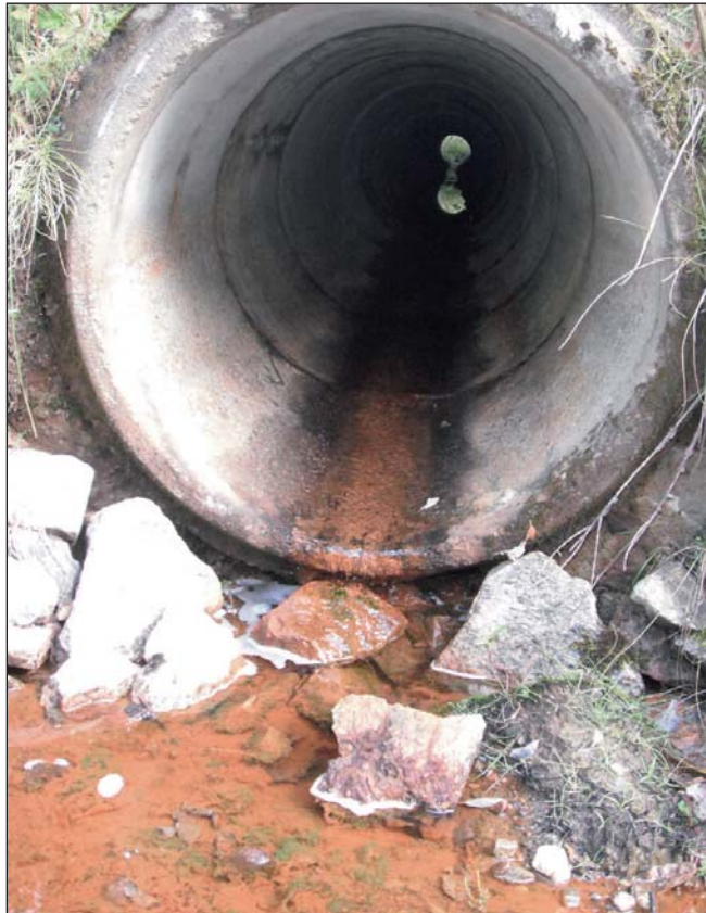
Photo 8 Aval du ponceau 0055-2 (drainage pluvial).
