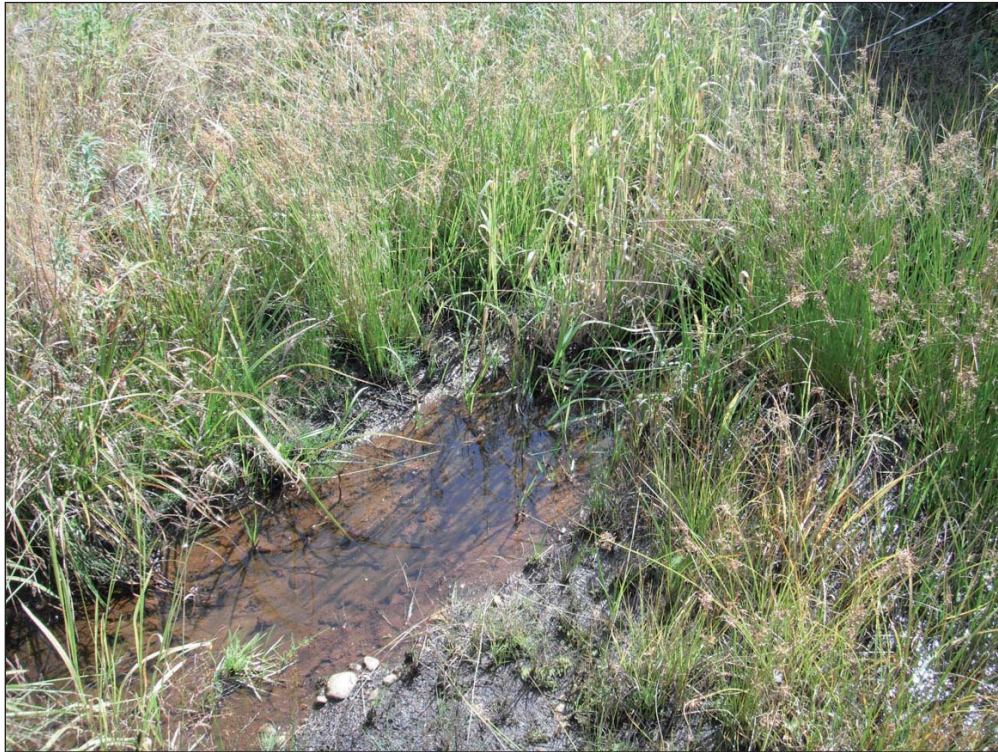
Photo 11 Aval du ponceau 0058-2 (drainage pluvial).
