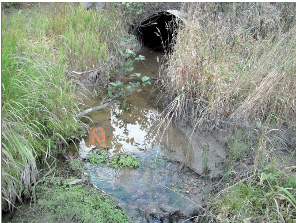
Photo 2 Aval du ponceau 0050-2 (cours d'eau intermittent).
