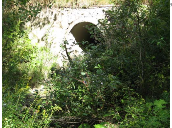
Cours d'eau et ponceau de route vu vers l'amont, du côté ouest de la route.
