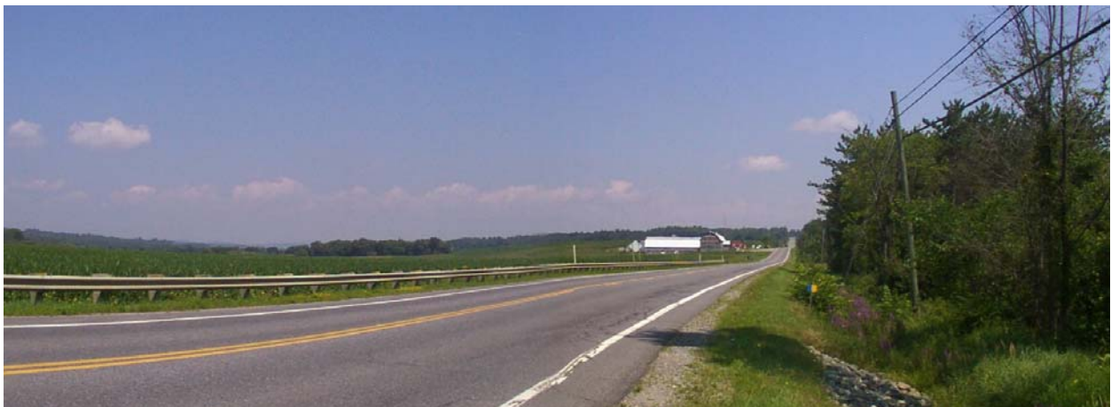
Photographie 9 : Vue vers le nord de la route 147 depuis l'extrémité sud du projet (2 août 2007).
