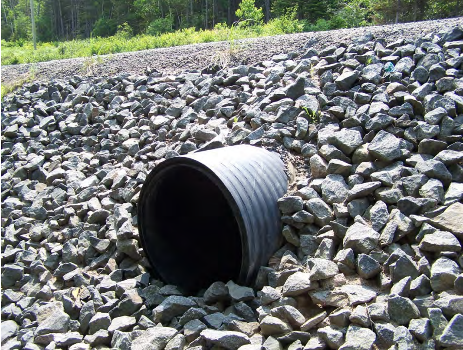
Photo 3 – Ponceau permettant à l’eau du fossé ouest de s’écouler vers l’est, à la hauteur du chainage 1+900. La photo montre son ouverture est et l’enrochement qui l’entoure.
