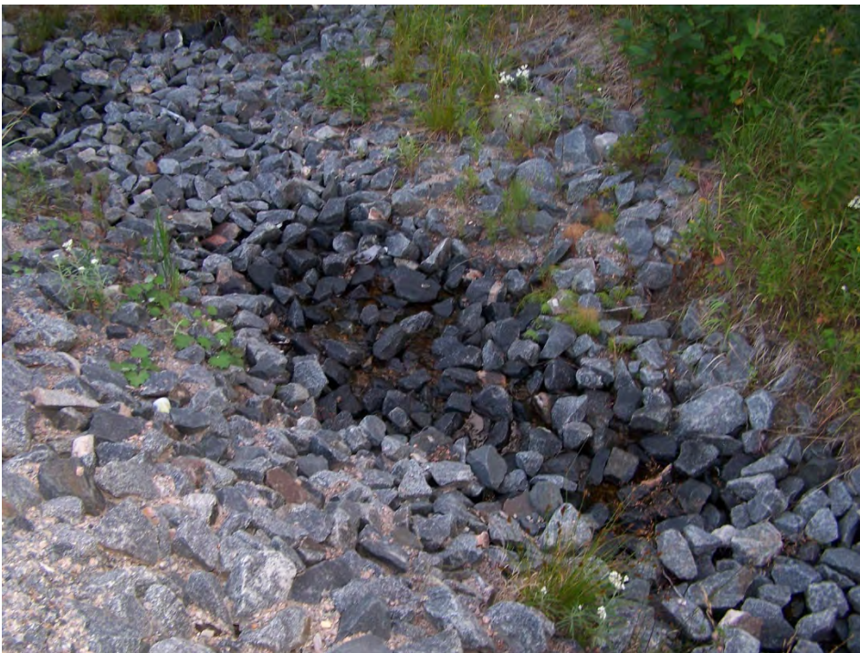
Photo 4 – Canal creusé du côté ouest de la route 138 à la hauteur du chainage 1+900 pour permettre d’évacuer une partie des eaux du fossé ouest de la route vers la végétation adjacente.
