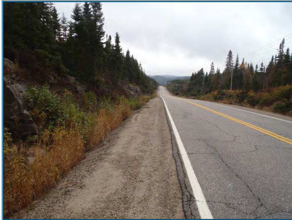
Photo 15 : Route 138 actuelle, chaînage 2+650
