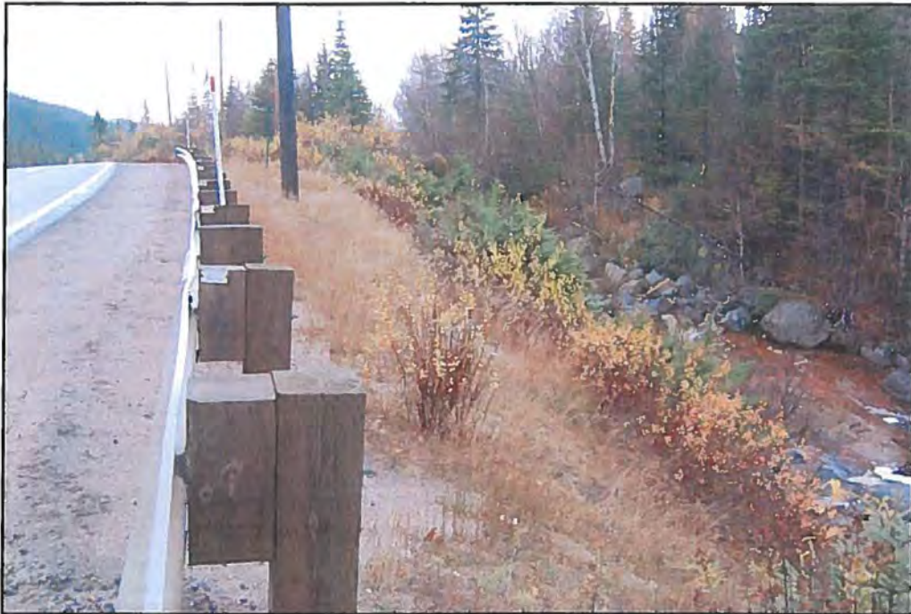
Photo 7 Projet n° 154-90-0166, secteur 1, vue de l'emprise au ch. 0+100, remblais de chaussée et ruisseau canalisé en marge de la chaussée, direction nord-ouest (PATR10N10-092)
