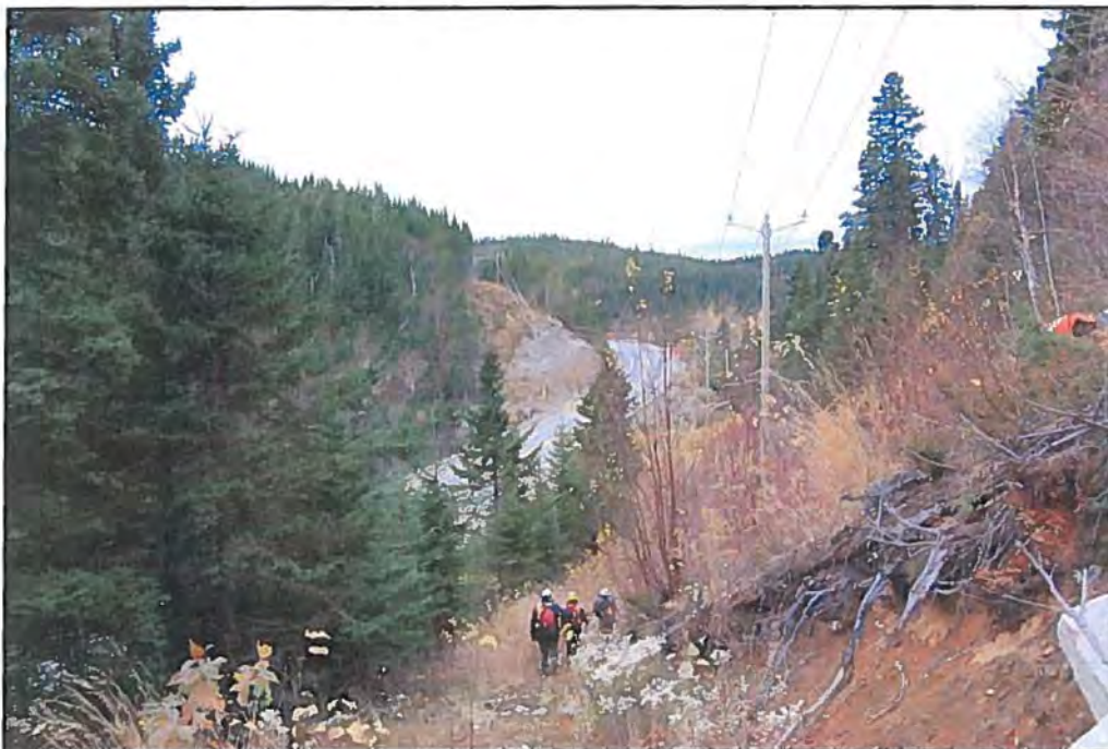
Photo 11 Projet n° 154-90-0166, secteur 3, vue de l'emprise au ch. 3+620, topographie ondulée, direction ouest (PATR10N10-045)
