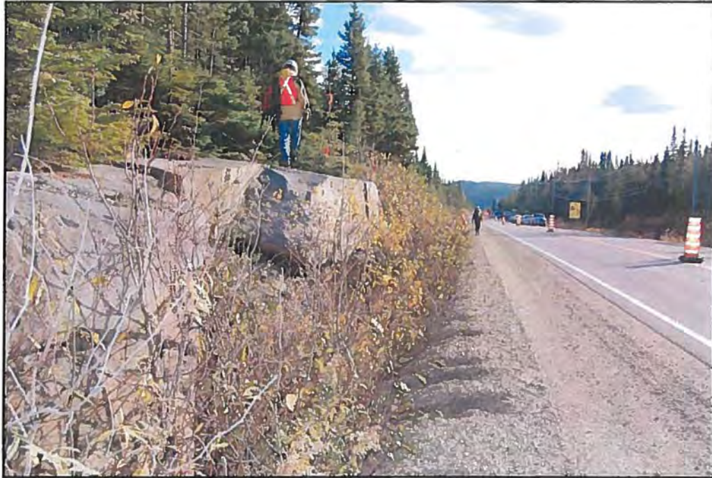
Photo 9 Projet n° 154-90-0166, secteur 2, vue de l'emprise au ch. 2+000, affleurement de roc dynamité en marge de la chaussée, direction sud (PATR10N10-075)
