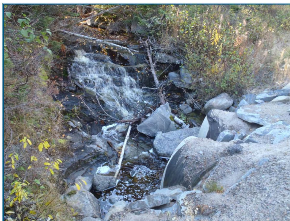
Photo 2 : Cascade du cours d'eau 2, en amont de la route 138
