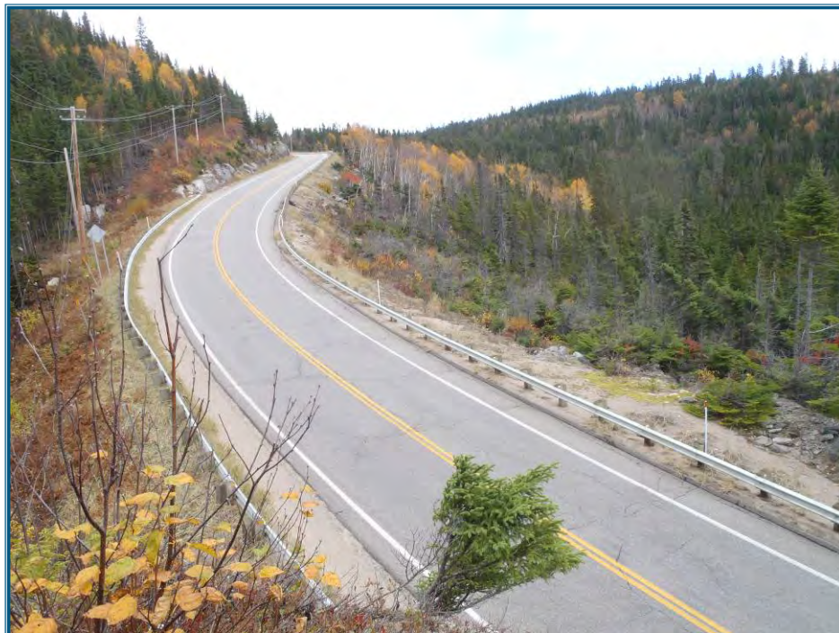
Photo 16 : Route 138 actuelle, chaînage 1+000
