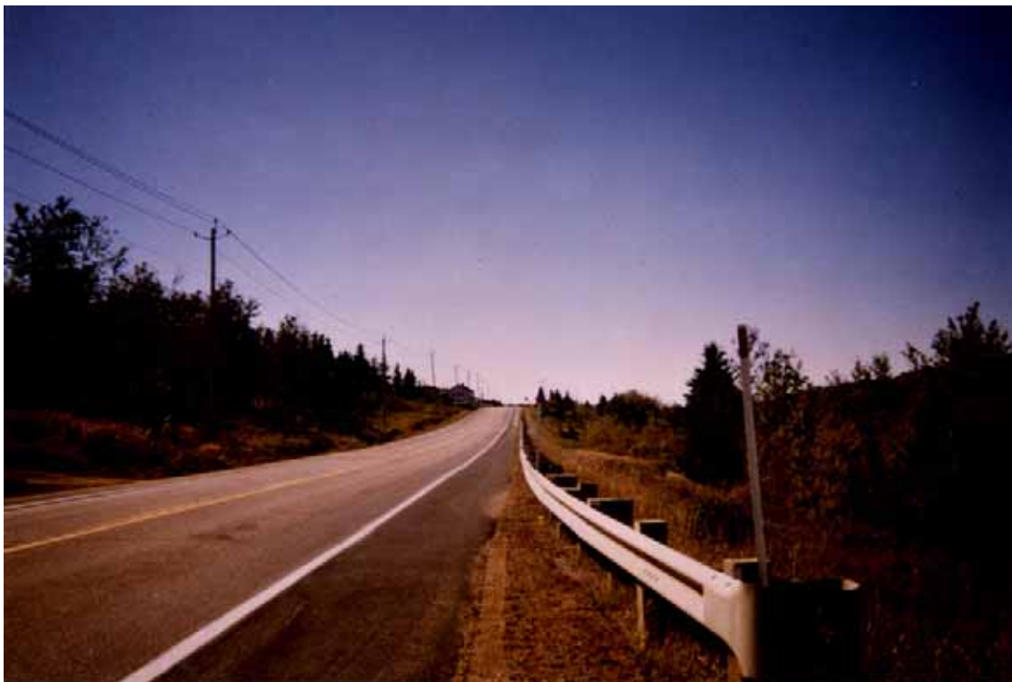
Point d'observation 3 : Direction ouest - Point bas (cuvette)
