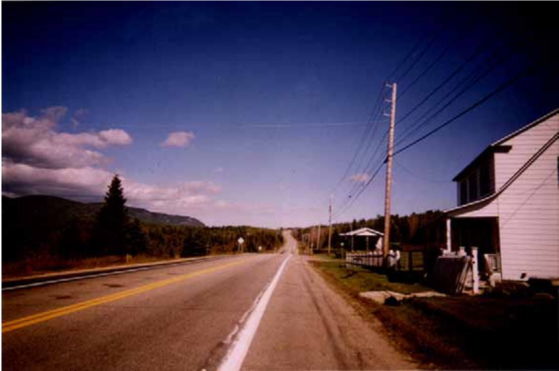
Point d'observation 5 : Direction est - Uniformité de la progression visuelle
