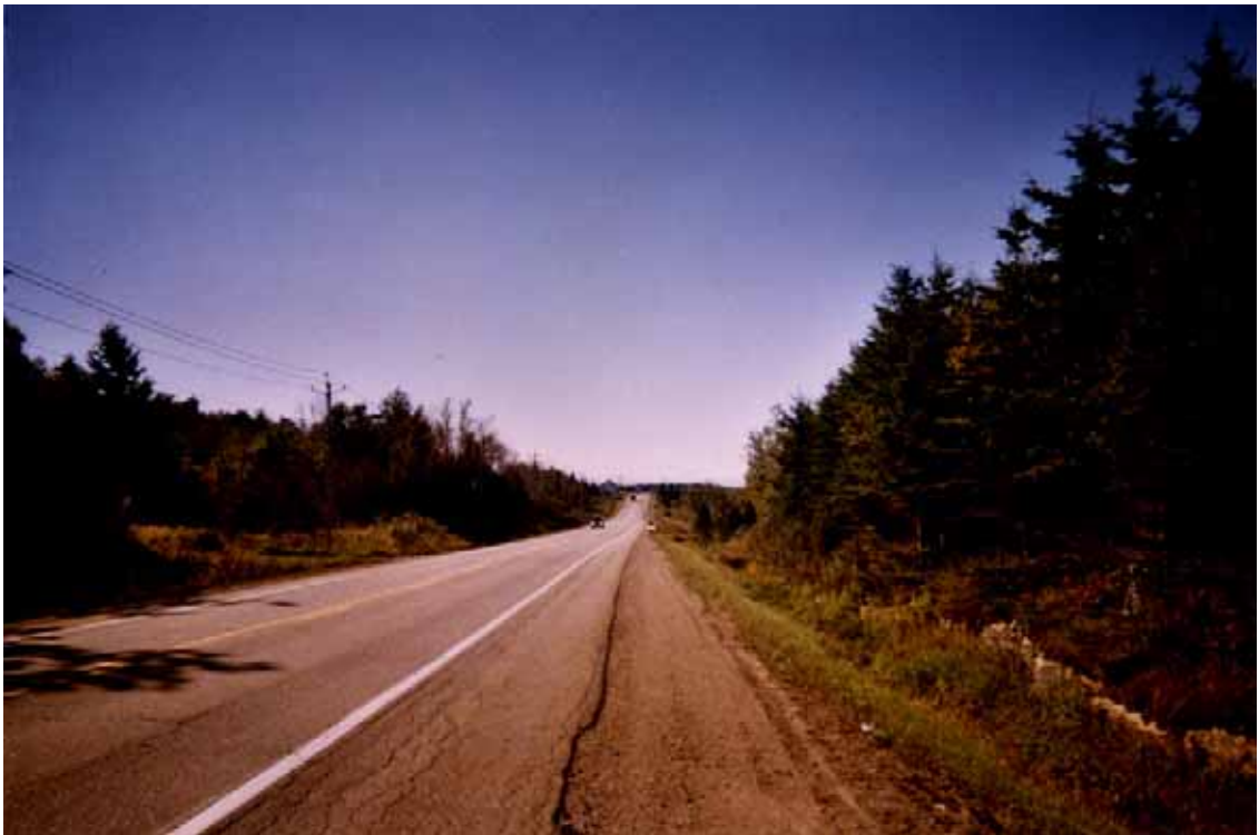
Point d'observation 2 : Direction ouest - Vue encadrée
