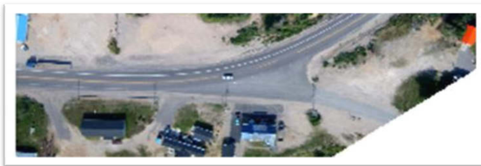
Figure 2.3 : Intersection entre la route 138 et la rue des Pionniers
