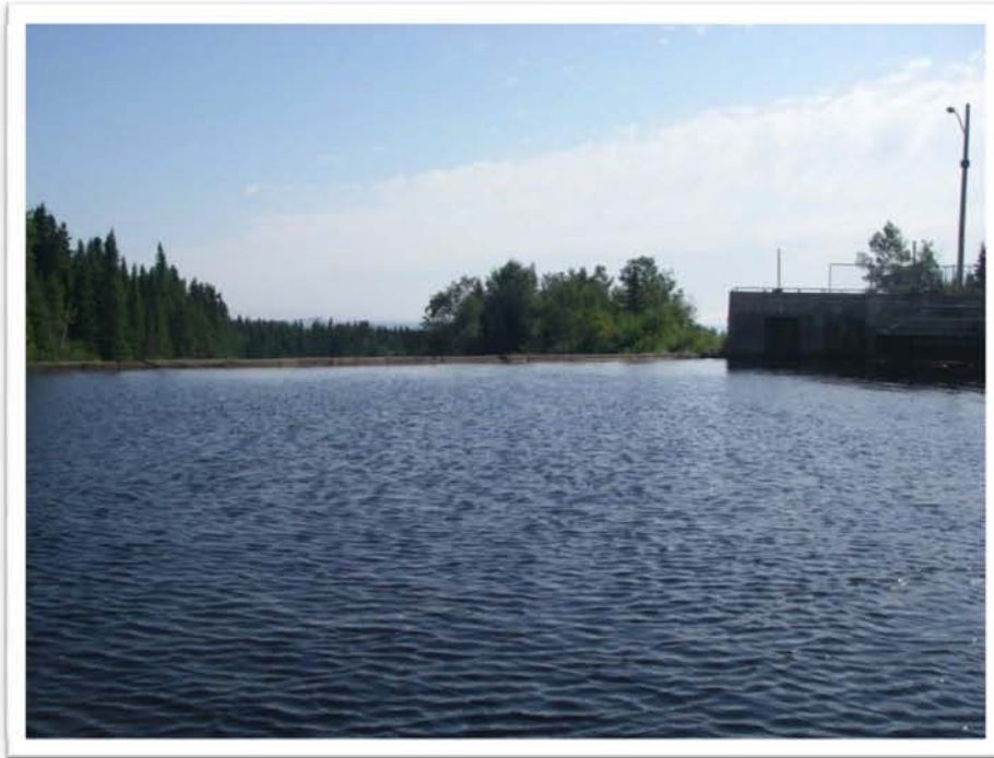
Photo 1 : Barrage situé sur la rivière Riverin (3 septembre 2008)
