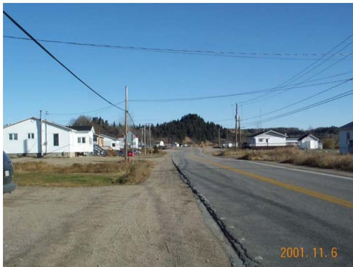
Photo n° 5. Vue d'une maison touchée par le raccordement est de la route de contournement avec la route 138 existante.
