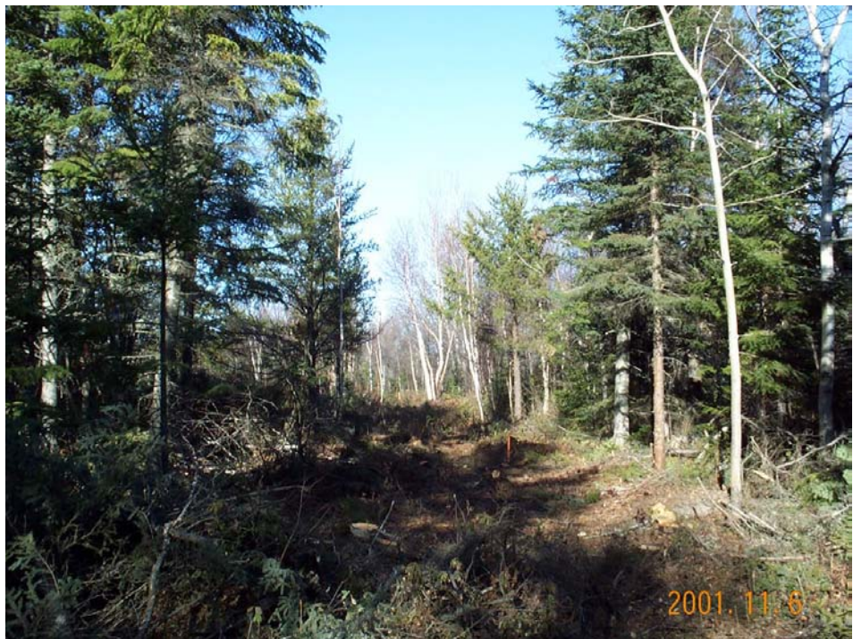
Photo n° 8. Milieu forestier traversé par le nouveau tronçon de la route 138.
