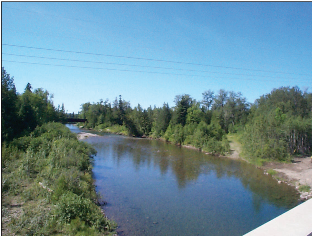
PHOTO 2 Secteur aval du pont de la route 132, à Escuminac.
