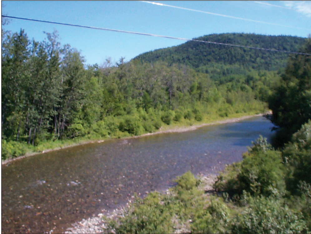
PHOTO 1 Secteur amont du pont de la route 132, à Escuminac.
