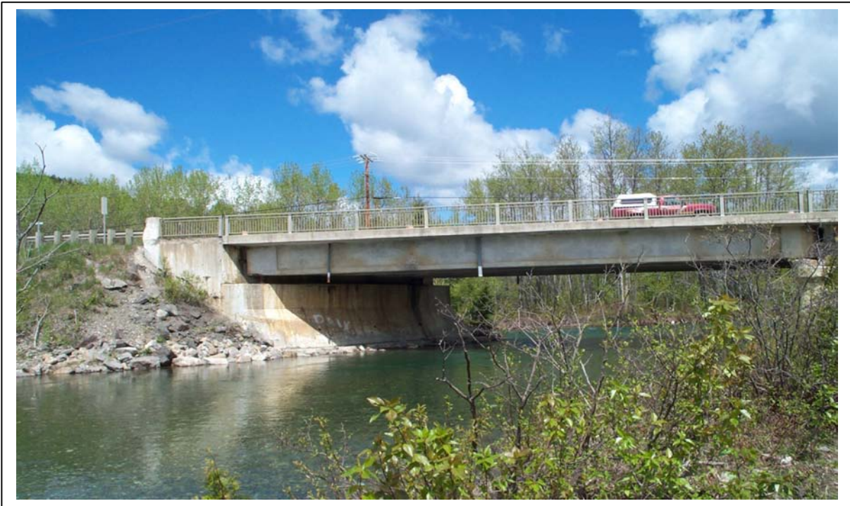
Photo 3 Vue aval de la travée ouest du pont de la rivière Escuminac.
