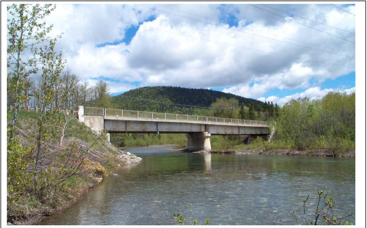
Photo 1 Vue aval du pont de la rivière Escuminac.
