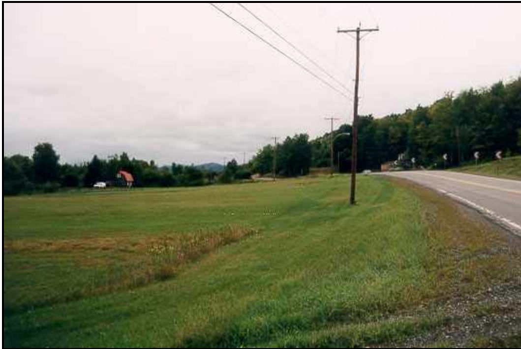
Photo 3: Déplacement du tracé sur ce terrain, propriété du # 383. Le bâtiment au toit rouge est à quelques mètres de l'emprise du projet.
