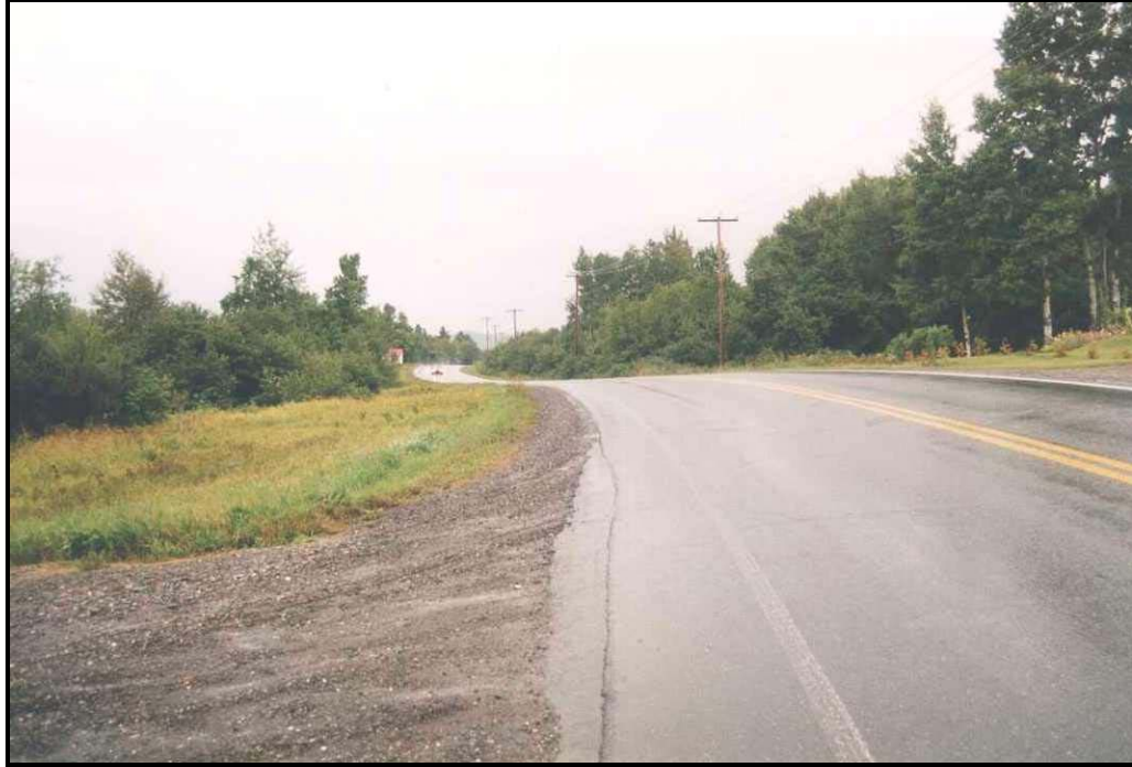
Photo 7: À partir du chemin Oatman, situé à la hauteur du # 319, vue vers l'ouest. Le nouveau tracé passe sur le terrain à gauche, dans l'alignement d'un des 2 hangars à exproprier dont l'un au toit rouge qu'on aperçoit dans la courbe.
