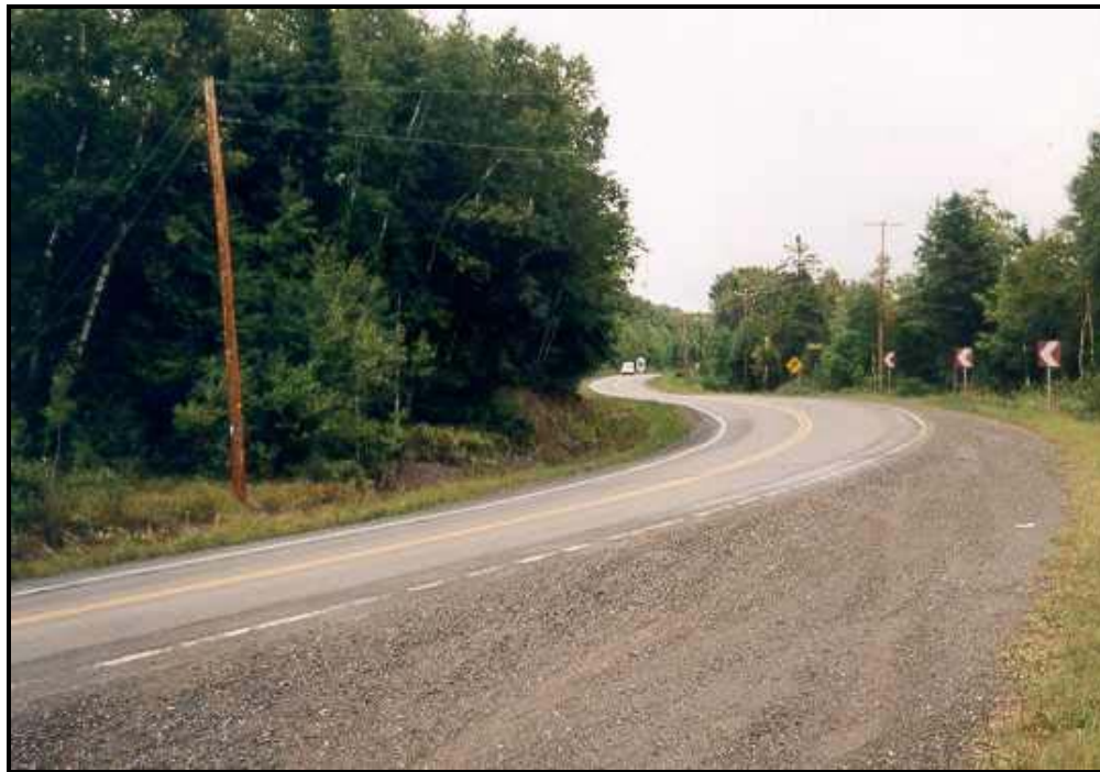
Photo 2: À partir de l'entrée du chemin McNeil, vue vers l'est. Les courbes (C5 et C4) sont sous standard et annoncées à une vitesse recommandée sécuritaire de 55 km/h.
