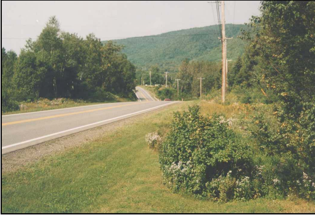
Photo 11: À partir du terrain de la résidence # 269, vue en direction sud-ouest du ravin aux approches du ruisseau Busteed. À noter la perte de visibilité du au profil et à la courbe C16.
