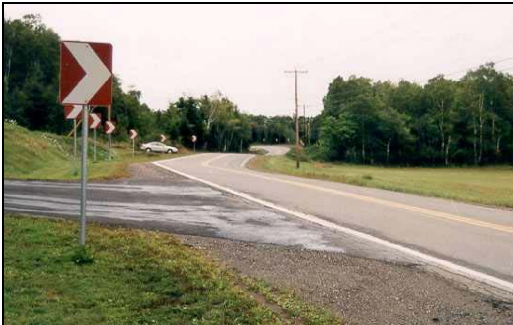
Photo 4: Vue vers l'est à partir de l'entrée du # 383 : courbes, profil déficient et problème de visibilité.
