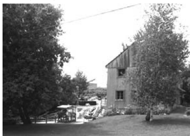
3.58. Vue du moulin à partir du chemin des Moulins. (SFV270)
