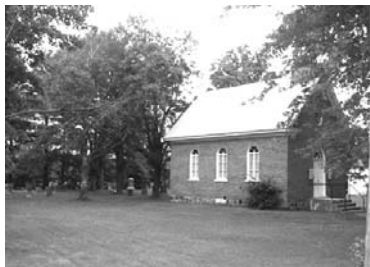
3.48. Façade ouest de l'église anglicane. (SFV343)
