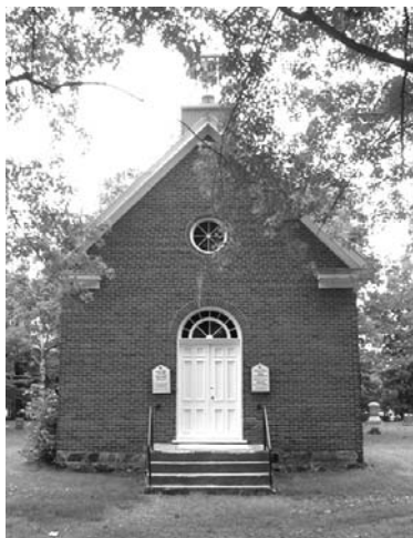
3.47. Façade principale de l'église anglicane. (SFV338)
