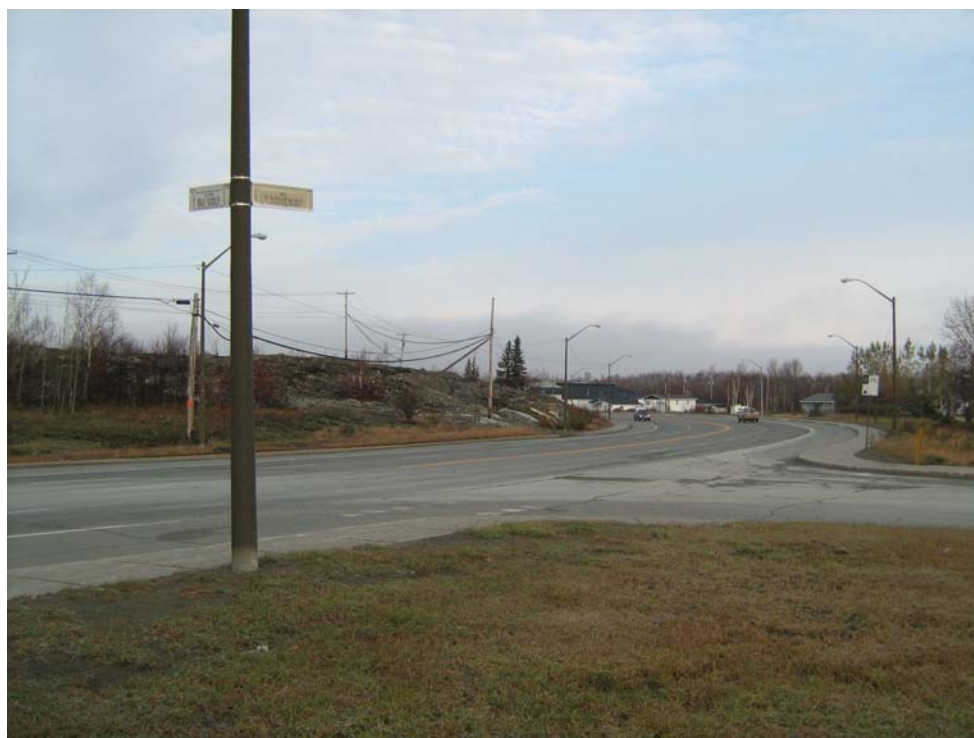
Photo 1 – Prise de vue, vers le nord-ouest, de la limite ouest de la zone à l'étude, à l'intersection de la rue Saguenay (route 101) et du chemin du Golf.
