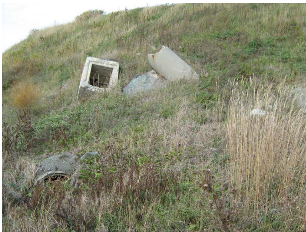
Photo 19 – Déchets photographiés dans les pentes du monticule de matériel importé (chaînage 5+600).
