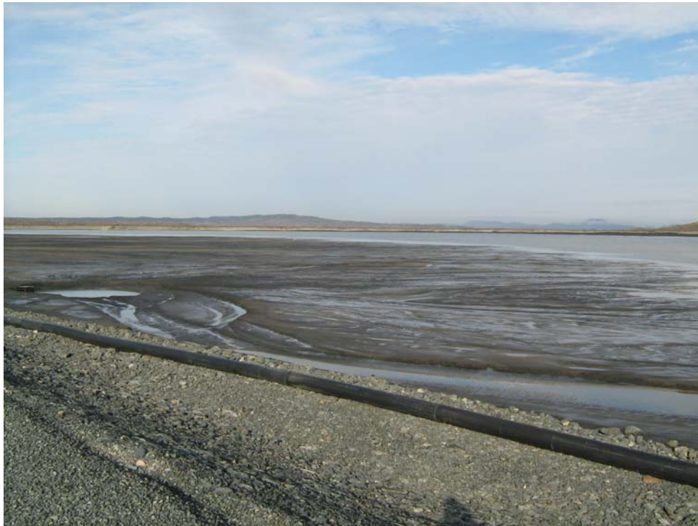
Photo 9 – Photographie du bassin de traitement de résidus miniers Quemont 2, prise à partir du dessus de la digue sud du bassin (Chaînage 1+500 à 2+500).
