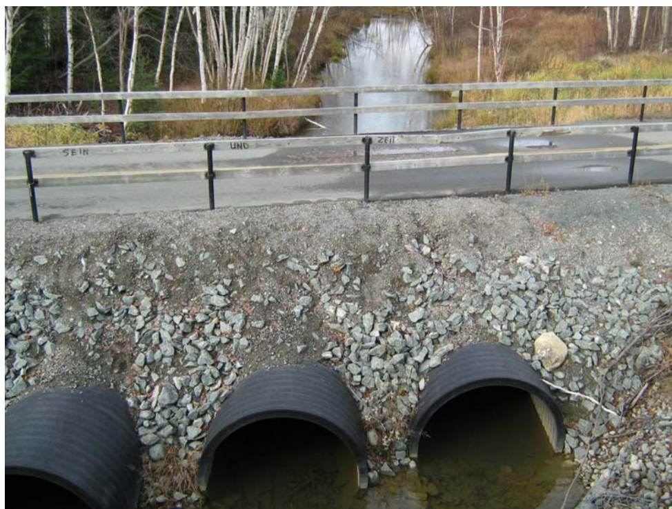
Photo 17 – Photographie, prise en direction ouest, du ruisseau Osisko, qui passe sous le pont de la rue Perreault Est et de la piste cyclable. (chaînage 4+900).
