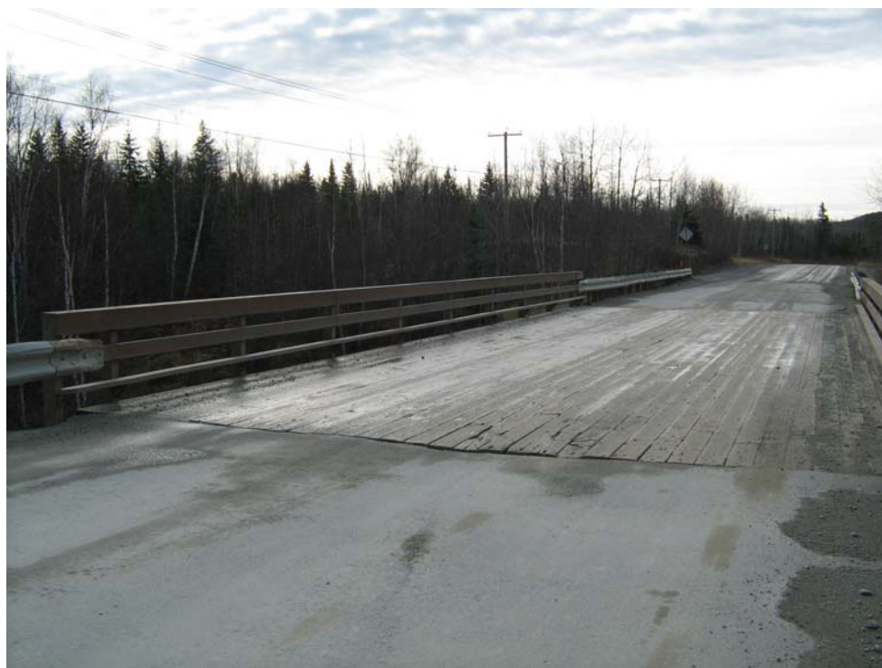
Photo 16 – Photographie, prise en direction sud, du pont construit sur la rue Perreault Est, sous le ruisseau Osisko (chaînage 4+900).
