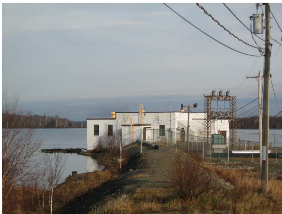
Photo 6 – Prise de vue des installations situées au nord de la ligne de pipelines, sur les berges du lac Dufault.
