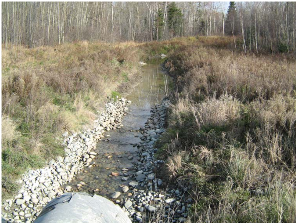
Photo 12 – Prise de vue d’un cours d’eau passant sous le chemin du Golf, localisé approximativement au chaînage 3+000.
