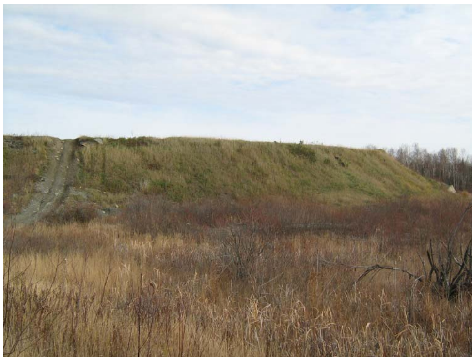
Photo 18 – Prise de vue du monticule de matériel importé, observé sur le long du côté est de la rue Perreault Est (chaînage 5+600).
