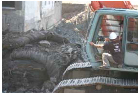
Figure 26 : Mesure des concentrations en CO lors des opérations d'excavation par la pelle
