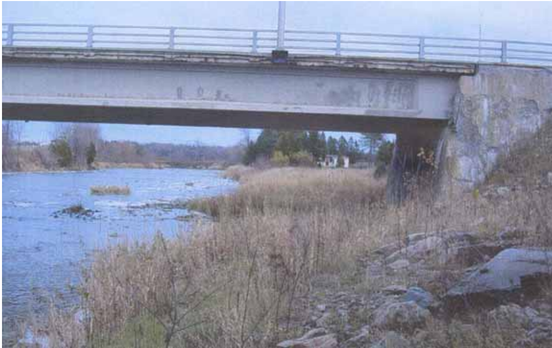
Photo 8 Pont sur la rivière Bulstrode
