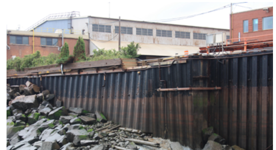
Mur de palplanches
