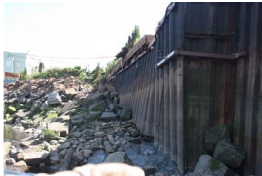
Photos 2 à 5 Vues du mur de palplanches montrant des perforations et déchirures des palplanches
