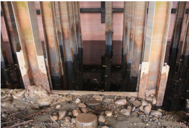
Photo 1 Vues du muret de soutènement sous le quai Duncan
