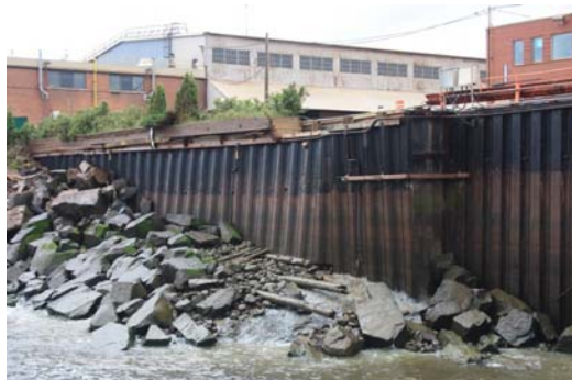
Photos 2 à 5 Vues du mur de palplanches montrant des perforations et déchirures des palplanches
