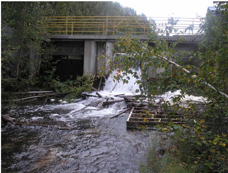
Photo 8 Vue de la sortie du déversoir du bassin de polissage, le 12 septembre 2007.
