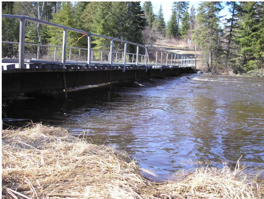
Photo 10 Pont au-dessus de la rivière Piché, le 4 mai 2007.
