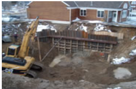
Terrain de Golf Hollinger (Pro Shop) Réhabilitation d'une zone d'effondrement
