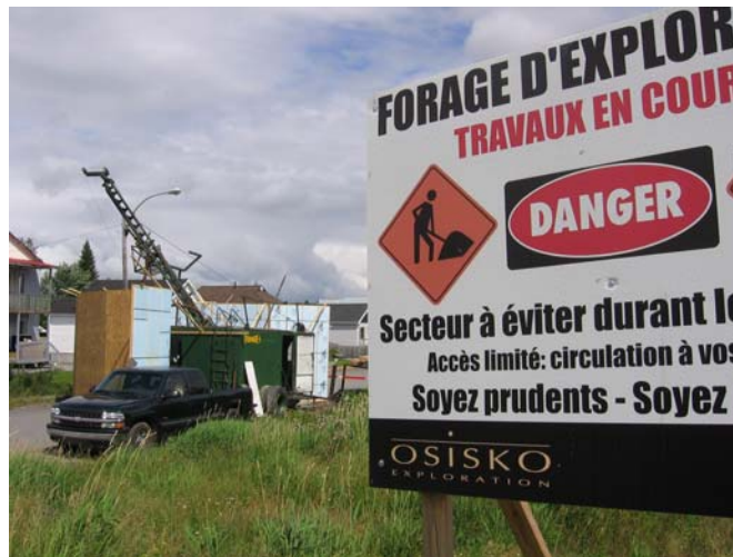
Figure 8.1 Sécurité et insonorisation sur un site de forage urbain
