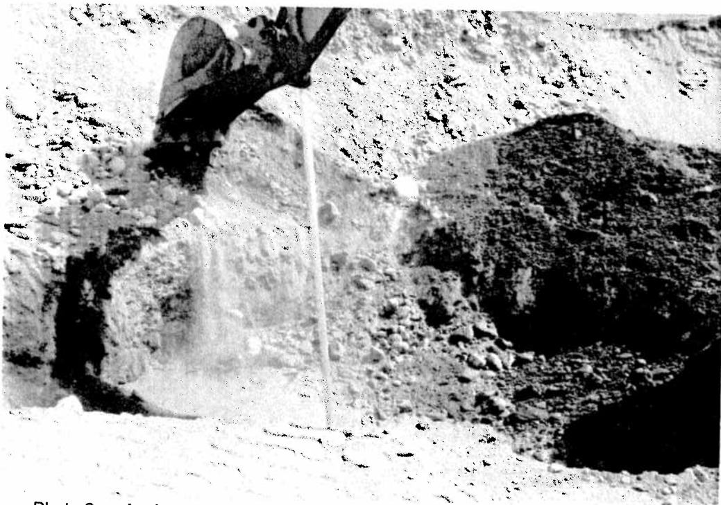
Photo 2. Aménagement d'un piézomètre (TR-9)
