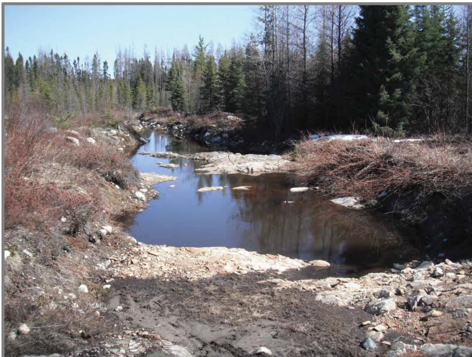
Photo 10 : Zone de décapage sur le site à l'étude
