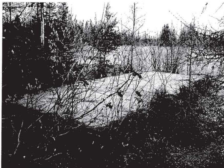
Photographie AKA-2010-05-05-006 Dalle de béton
