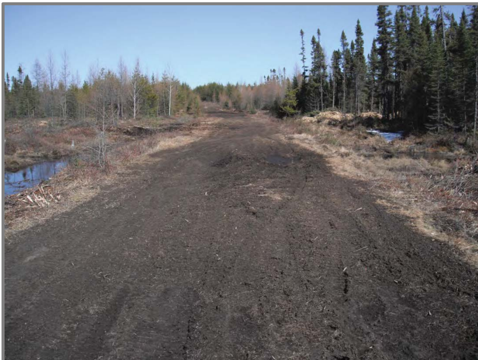
Photo 14 : Chemin d'accès au centre du site à l'étude (direction est)
