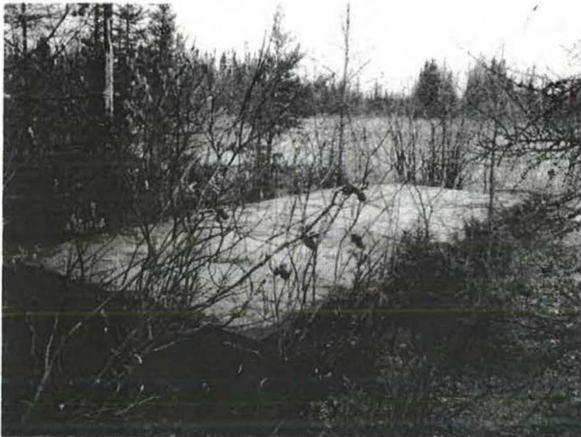
Photographie AKA-2010-05-05-006 Dalle de béton
