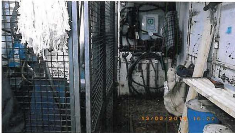
IMGP0703 (Large).JPG Aucune fuite dans le bâtiment de forage.
