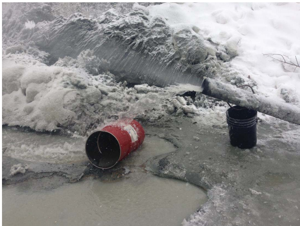
Photographie 22 : Développement du puits d'essai à l'air comprimé
