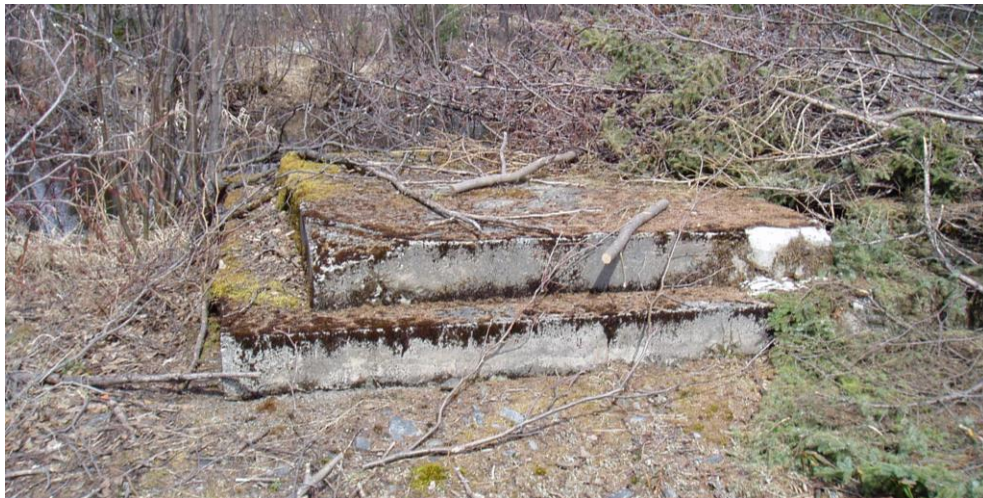
Figure 4 Entrée bétonnée d'une cheminée de la Mine Akasaba en 2011 (Grenier, 2016).
