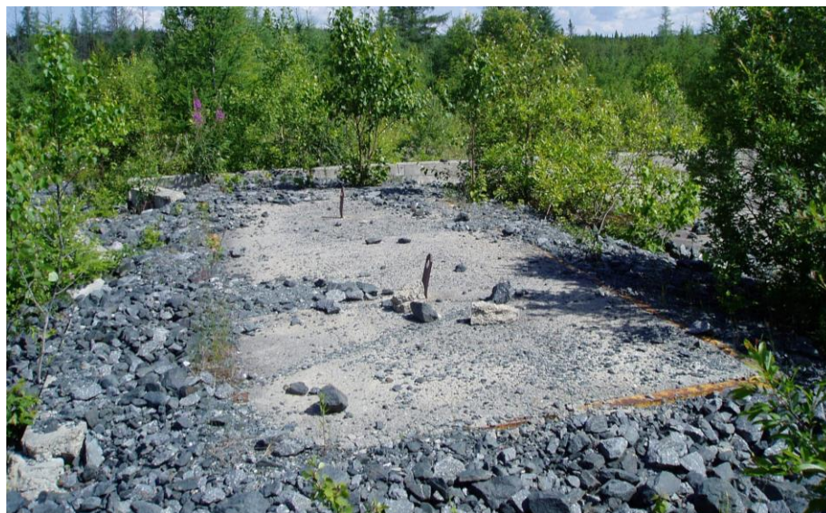
Figure 2 Entrée bétonnée du puits de la Mine Simkar en 2009 (Grenier, 2016).
