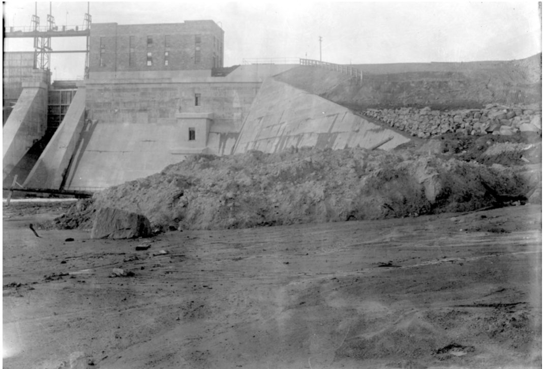
Photo n° 11. Aspect de la berge en aval du barrage Matawin (22 août 1931; Archives nationales du Québec)
