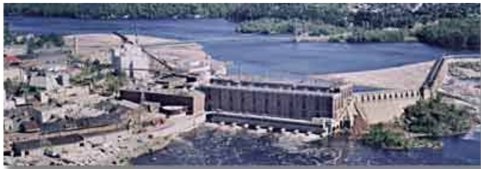
Photo n° 6. Centrale hydroélectrique de Grand-Mère (Hydro-Québec).
