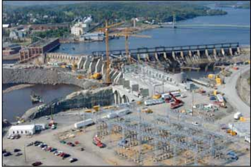
Photo n° 7. Chantier de la nouvelle centrale hydroélectrique de Grand-Mère (Hydro-Québec).
