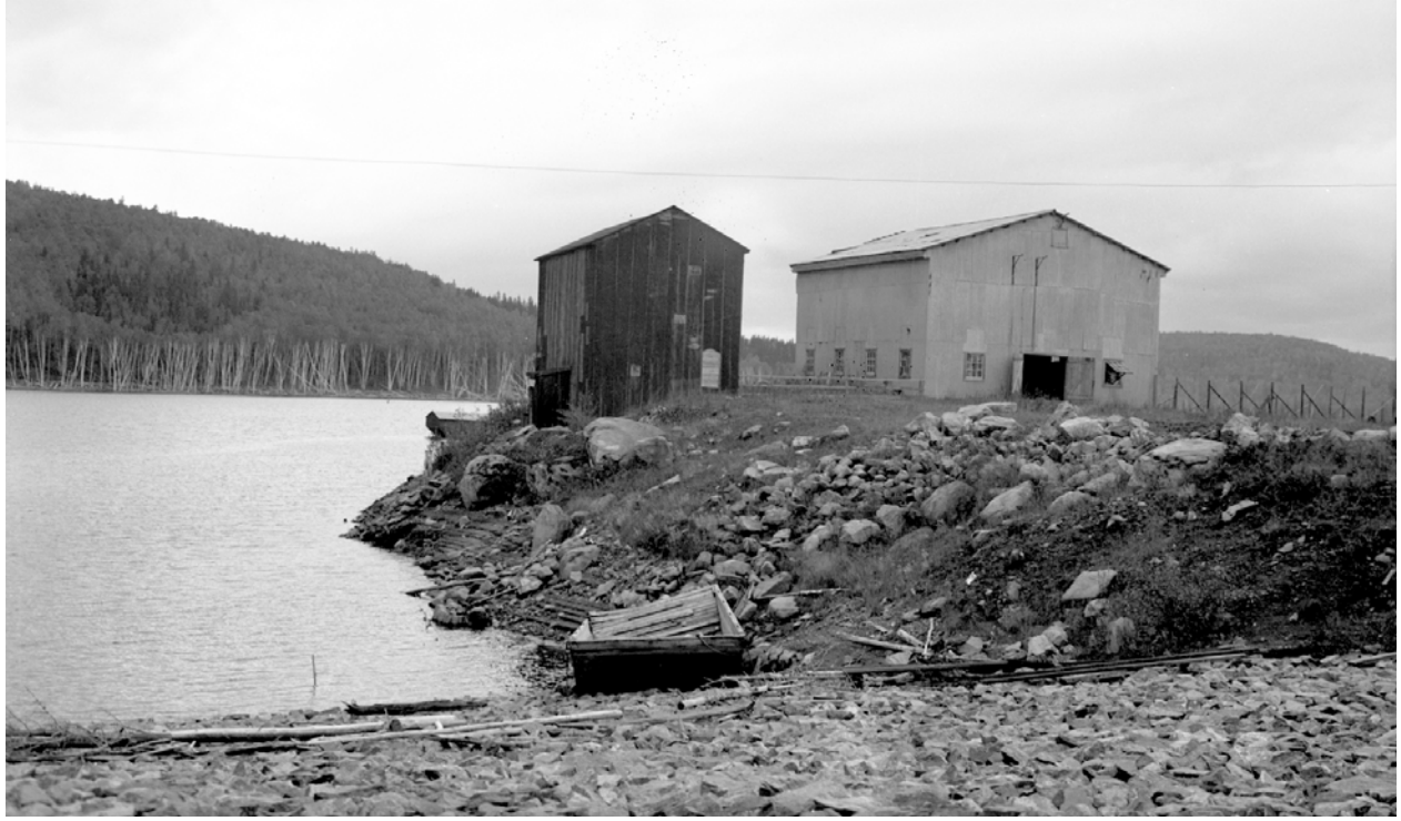
Photo n° 17. Entrepôts d'huile et de matériaux en amont du barrage Matawin (1 er octobre 1935; Archives nationales du Québec).
