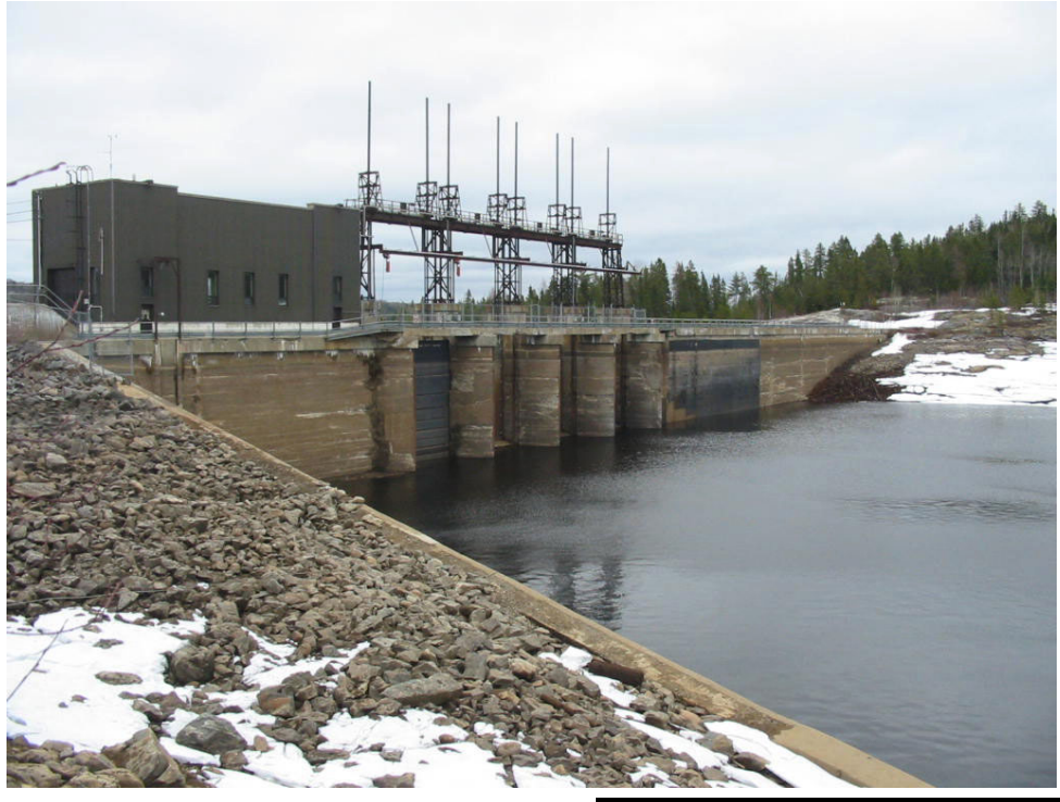
Photo n° 7 Vue amont du barrage.
