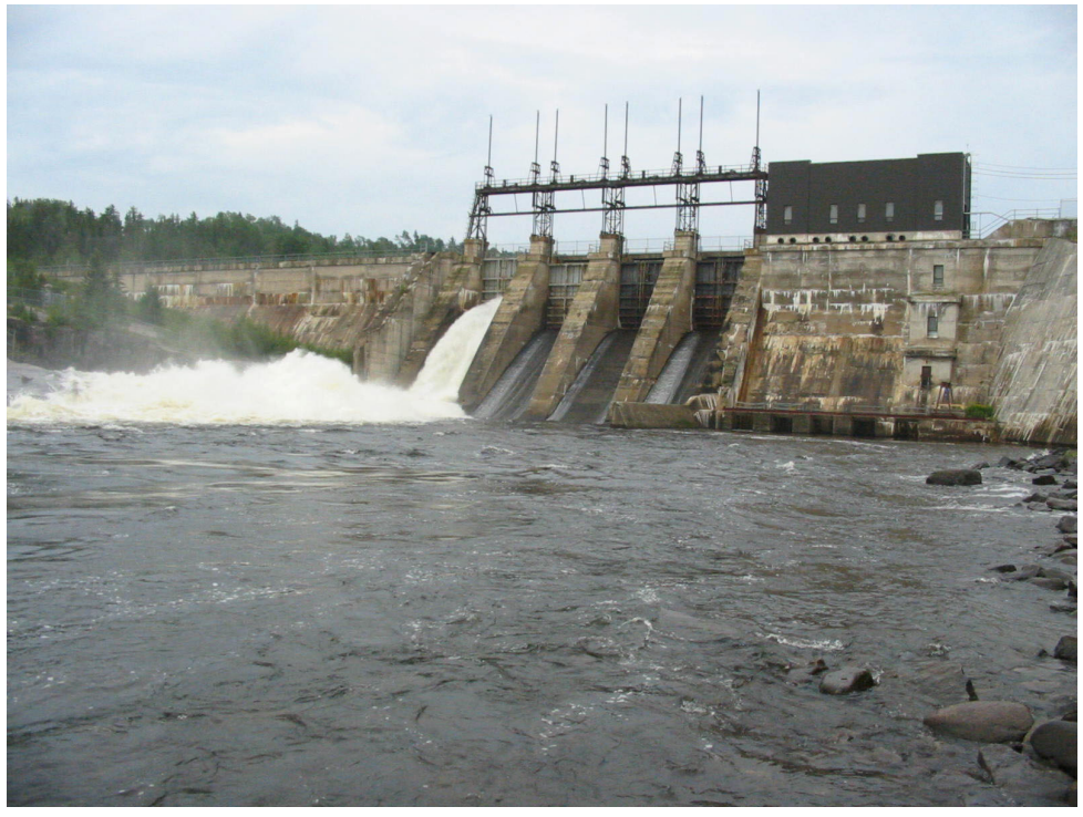
Photo n°8 Vue aval du barrage.
