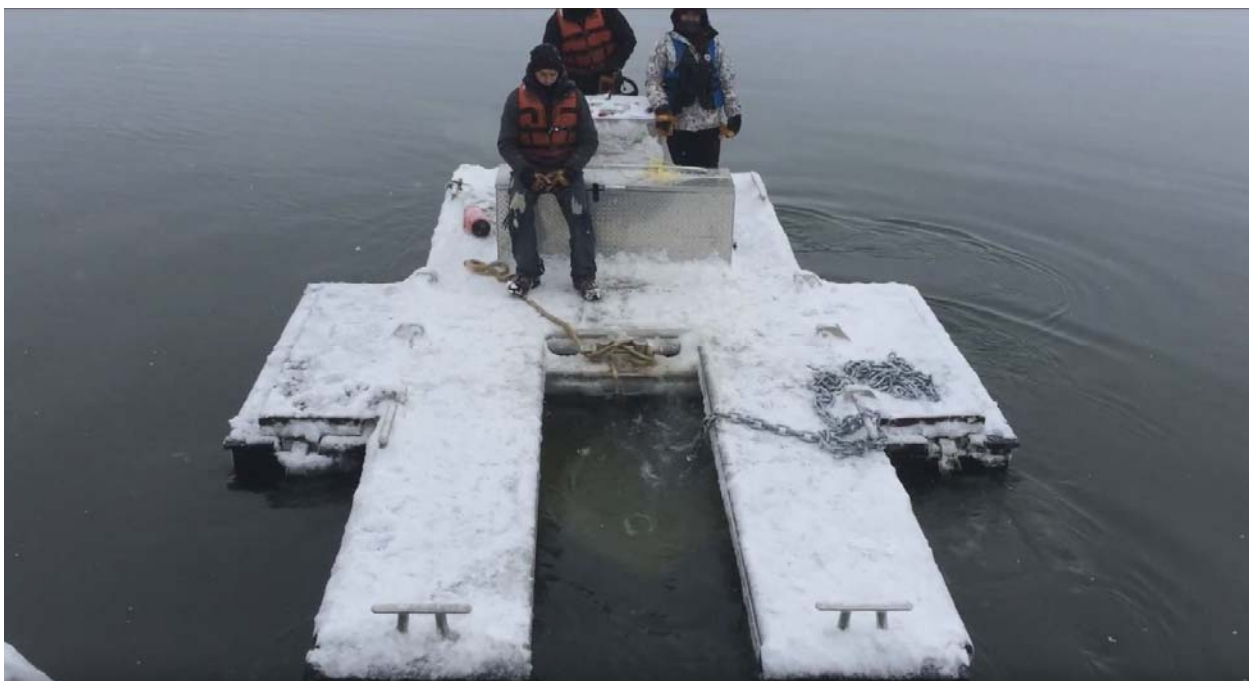
Photo 34 : Embarcation motorisée transportant un bloc d'ancrage immergé et suspendu sous l'embarcation (2014-12-09).
