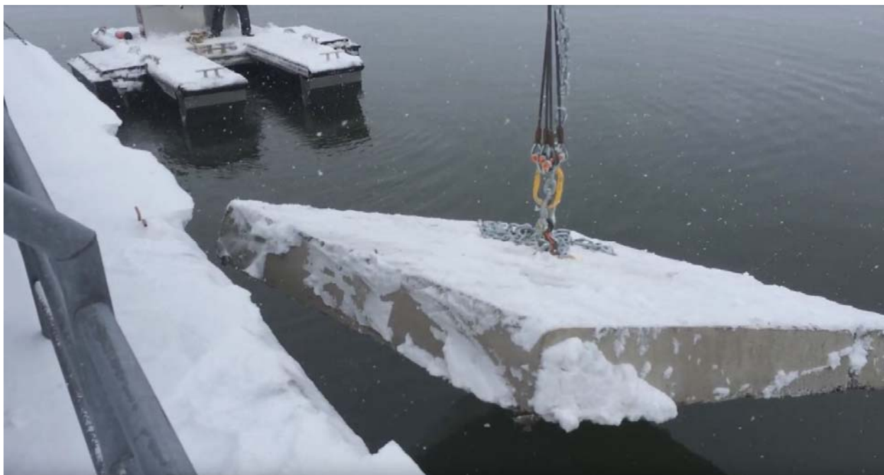
Photo 33 : Bloc d'ancrage transporté à l'aide d'une grue pour la mise à l'eau (2014-12-09).
