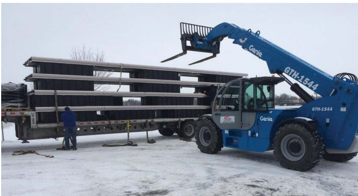
Photo 32 : Ponton transporté à l'aide d'une grue mobile pour la mise à l'eau (2014-12-09).
